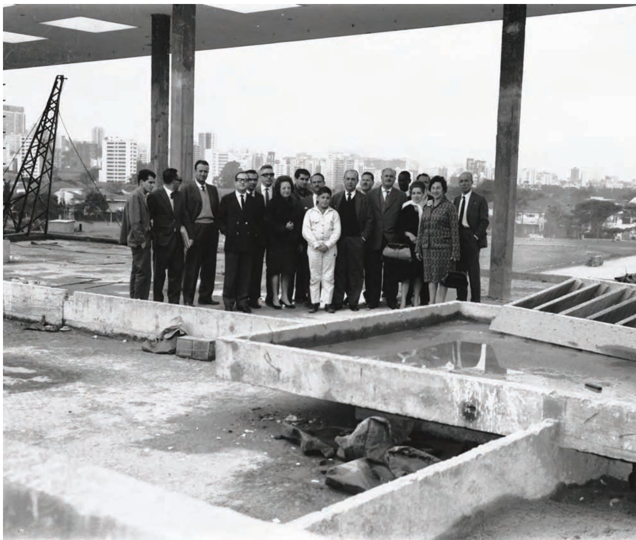
Visita da Mesa Diretora às obras do novo prédio - 16.7.65
