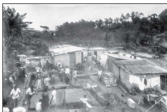
2. Construção das casas em mutirão. Fonte: arquivo Elita Pereira Matos/1984
