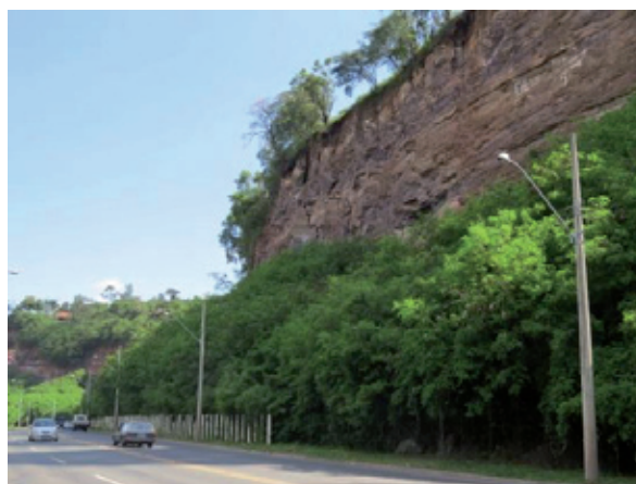
Foto 6. Vista lateral de paredão rochoso que apresenta condições favoráveis para geração de quedas e deslocamentos rochosos. Notar estrutura plano-paralela e grau de fraturamento do maciço.
