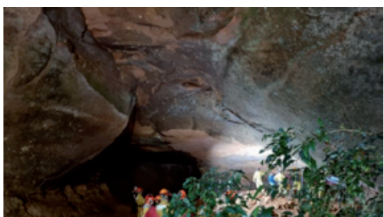
Foto 2. Visão do local do acidente, com destaque para o maciço rochoso (arenitos fraturados) e as dimensões da cavidade (Foto: Instituto de Pesquisas Ambientais).
