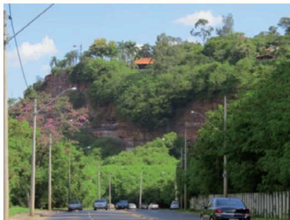
Foto 5. Vista geral de paredão rochoso que apresenta condições favoráveis para geração de quedas e deslocamentos rochosos.
