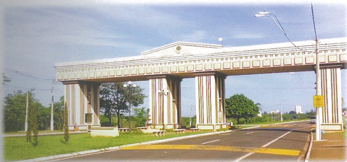
Figura 39: Pórtico – Fonte: PMS.
