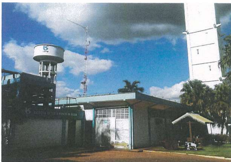
Fig. 123: ETA – Estação de Tratamento de Água – Fonte: PMPF.
