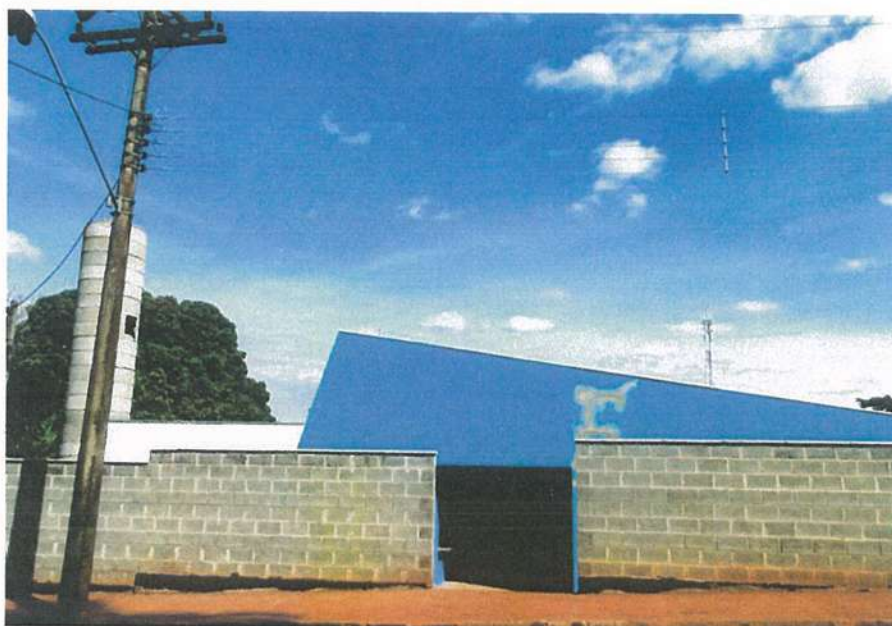
Fig. 148: Creche Escola em construção- Fonte: PMPF.
