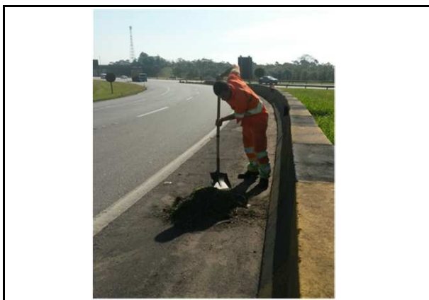
Foto 11 SPI 040 Km 1 ao 8 Oeste Varrição e Capinagem Data da Constatação 11/05/17
