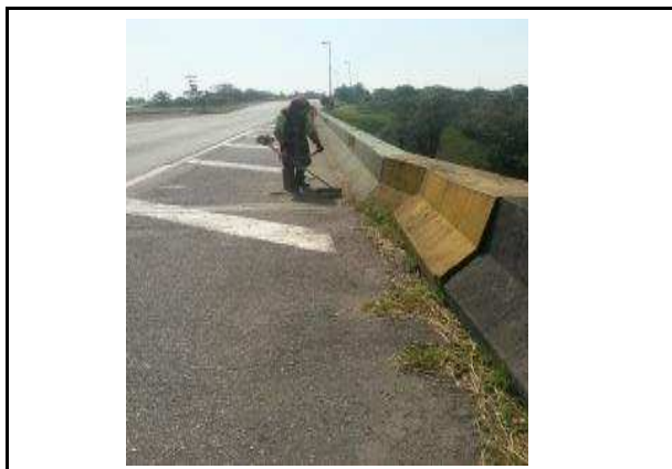
Foto 10 SPI 040 Km 1 ao 8 Oeste Varrição e Capinagem Data da Constatação 11/05/17
