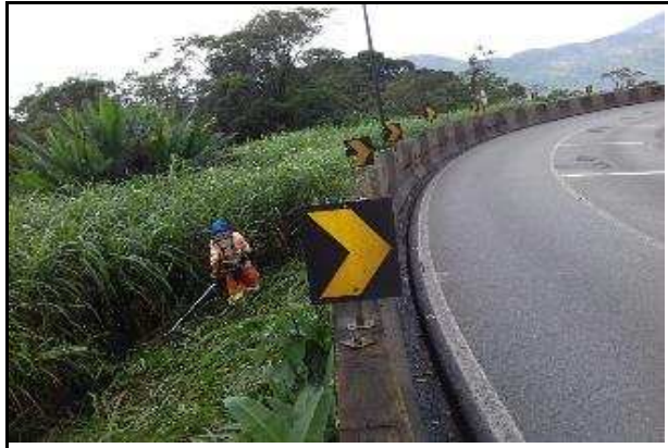
Foto 10 SP 150 Km 44+800 Sul Roçada Manual Data da Constatação 04/05/17
