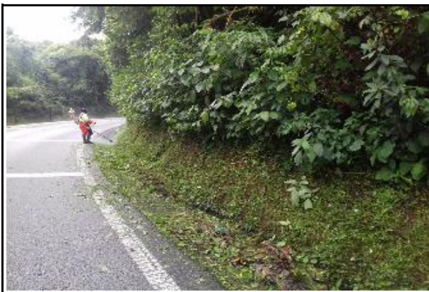
Foto 18 SP 150 Km 47,000 Sul Roçada Manual Data da Constatação 09/05/17
