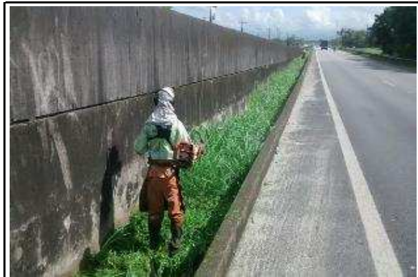
Foto 4 SPA 248 Km 8,000 Leste Roçada Manual Data da Constatação 08/05/17
