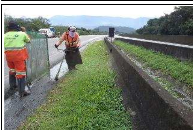
Foto 53 SP 150 Km 58,000 Sul Roçada Manual Data da Constatação 17/05/17
