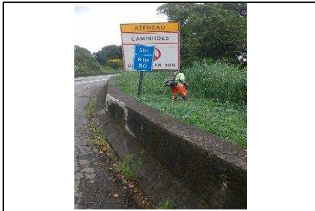
Foto 12 SP 150 Km 50,000 Sul Roçada Manual Data da Constatação 04/05/17
