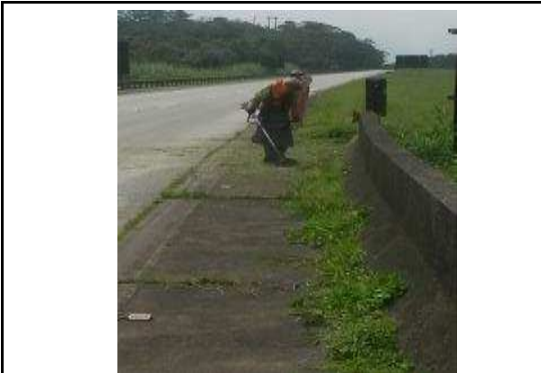
Foto 3 SPI 040 Km 1 ao 8 Leste Varrição e Capinagem Data da Constatação 10/05/17
