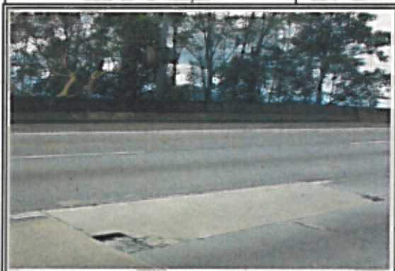
FOTO 05: SP-160 - Km 46+600 Norte Reparo em pavimento rígido - faixa 3
