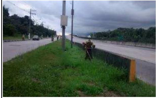
Foto 32 SP 055 Km 284+500 Leste Roçada Manual Data da Constatação 16/05/17
