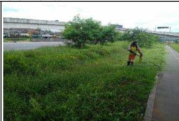
Foto 44 SP 150 Km 48,000 Sul Roçada Manual Data da Constatação 17/05/17
