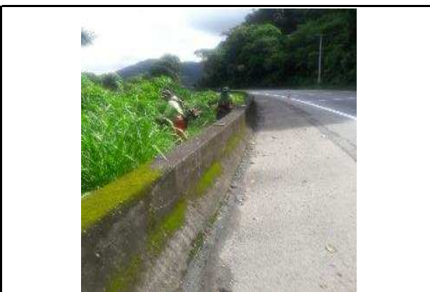
Foto 27 SP 150 Km 53,000 Sul Roçada Manual Data da Constatação 11/05/17
