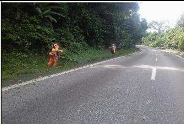
Foto 14 SP 150 Km 51+600 Sul Roçada Manual Data da Constatação 04/05/17
