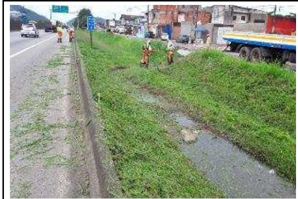
Foto 8 SPA 248 Km 4,000 Leste Roçada Manual Data da Constatação 23/05/17
