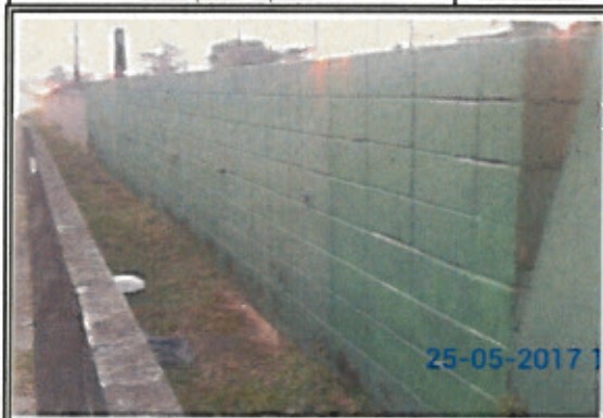
FOTO 02: SP-055 PMN - Km 283+700 Leste
