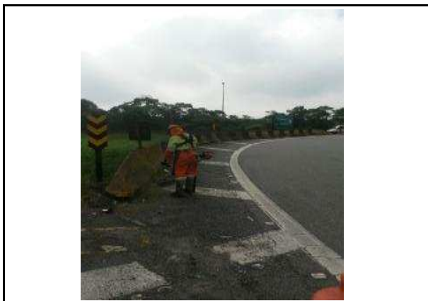
Foto 9 SPI 040 Km 1 ao 8 Oeste Varrição e Capinagem Data da Constatação 11/05/17
