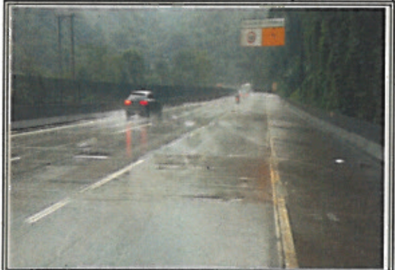
FOTO 13: SP-055 CDR - Km 253+700 Oeste
