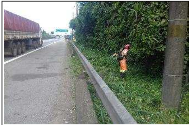
Foto 34 SP 150 Km 54,000 Sul Roçada Manual Data da Constatação 15/05/17
