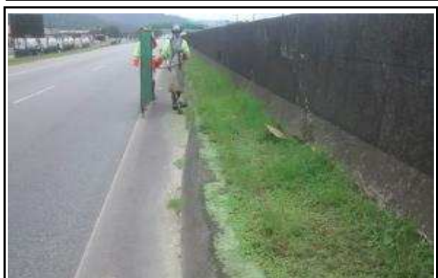
Foto 18 SP 055 Km 286,000 Oeste Roçada Manual Data da Constatação 10/05/17
