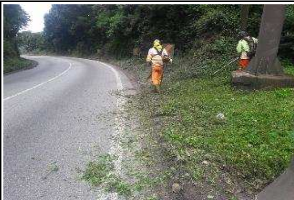
Foto 9 SP 150 Km 48+500 Sul Roçada Manual Data da Constatação 04/05/17
