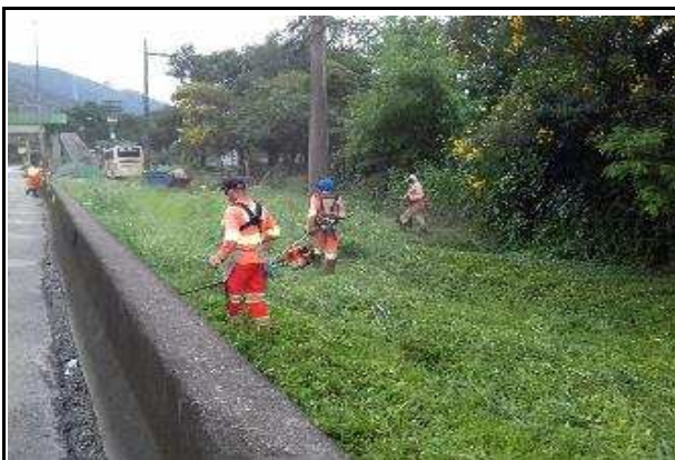
Foto 16 SP 150 Km 52,000 Sul Roçada Manual Data da Constatação 04/05/17
