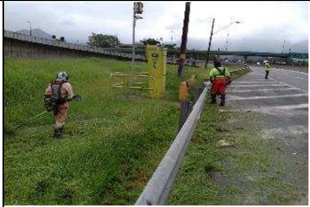
Foto 8 SP 150 Km 59+800 Sul Roçada Manual Data da Constatação 04/05/17
