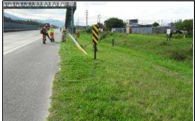
Foto 22 SP 055 Km 291,000 Leste Roçada Manual Data da Constatação 16/05/17
