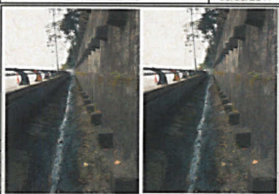
FOTO 06: SP-160 - Km 46+600 Norte Serviço executado
