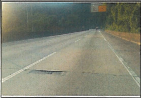
FOTO 13: SP-055 CDR - Km 253+700 Oeste
