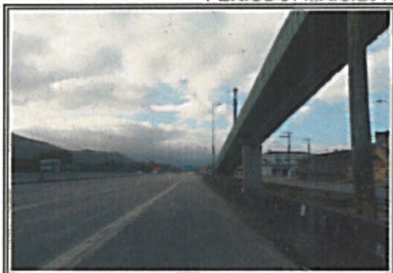
FOTO 01: SP-055 PMN - Km 280+600 ao 280+550 Leste
