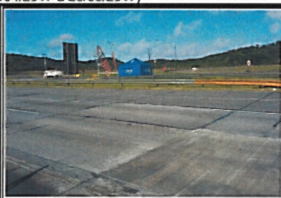
FOTO 04: SP-160 - Km 40+950 Norte Serviço executado
