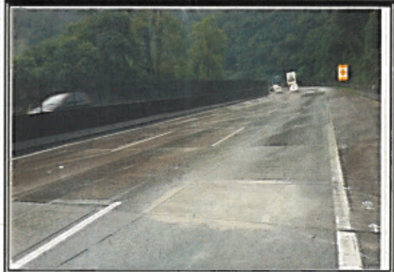
FOTO 12: SP-055 CDR - Km 253+800 Oeste
