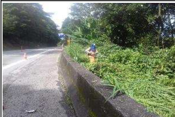
Foto 13 SP 150 Km 51+600 Sul Roçada Manual Data da Constatação 04/05/17
