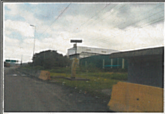
FOTO 09: SP-055 CDR - Km 266+400 Oeste
