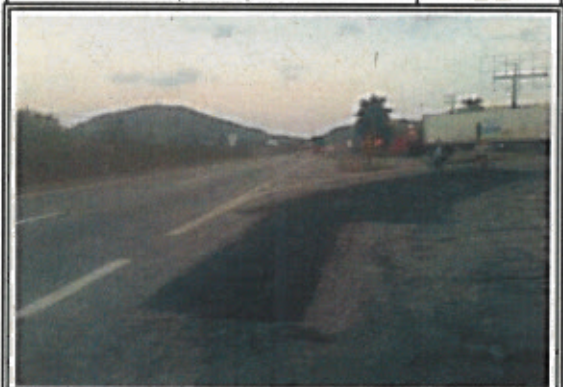
FOTO 03: SPA-248 - Km 5+300 Leste
