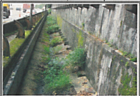
FOTO 06: SP-160 - Km 46+600 Norte Limpeza de canaleta
