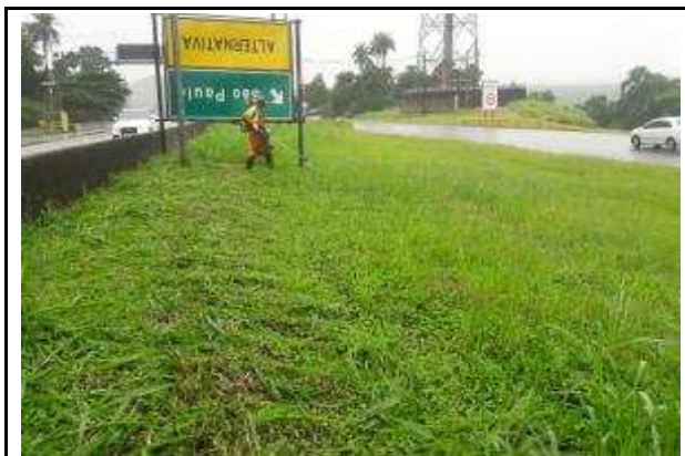
Foto 5 SP 160 Km 58,000 Sul Roçada Manual Data da Constatação 10/05/17
