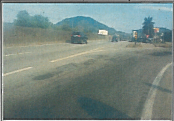
FOTO 03: SPA-248 - Km 5+300 Leste
