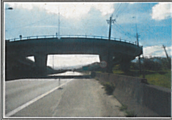
FOTO 04: SPA-248 - Km 2+900 ao 2+800 Oeste
