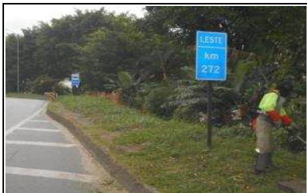
Foto 28 SP 055 Km 272,000 Leste Roçada Manual Data da Constatação 16/05/17
