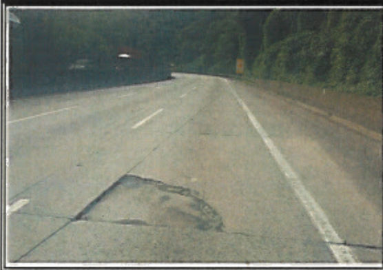
FOTO 12: SP-055 CDR - Km 253+800 Oeste
