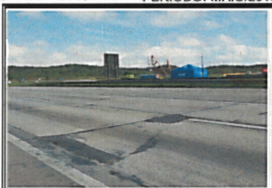
FOTO 04: SP-160 - Km 40+950 Norte Reparo em pavimento rígido - faixa 4
