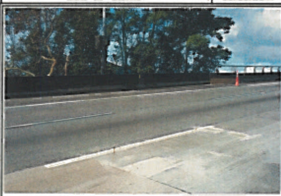
FOTO 05: SP-160 - Km 46+600 Norte Serviço executado
