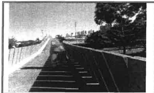
Limpeza da Passarela SP-150 - Km11+060
