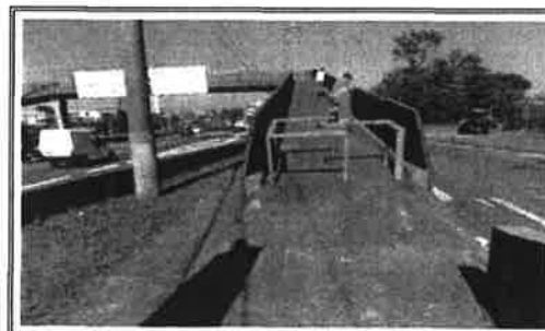
Limpeza da Passarela SP-150 - Km11+060
