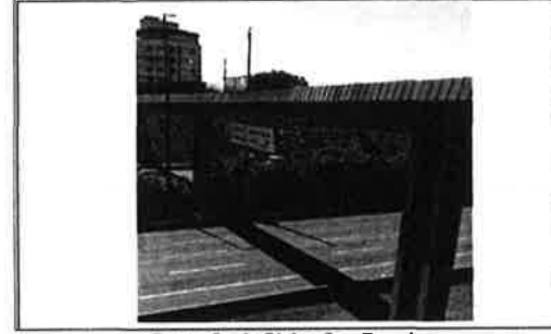
Remoção de Pichação - Depois SP-160 - Km13+589
