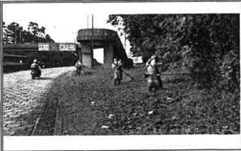
Roçada não acesso a Passarela SP-150 - Km29+813
