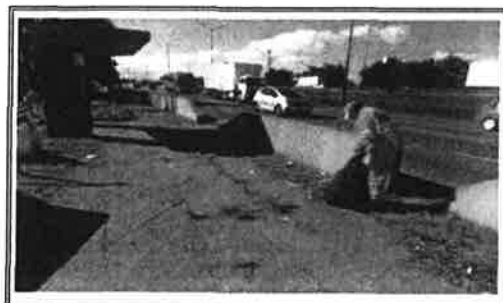
Limpeza da passarela e seu entorno SP-150 - Km18+000
