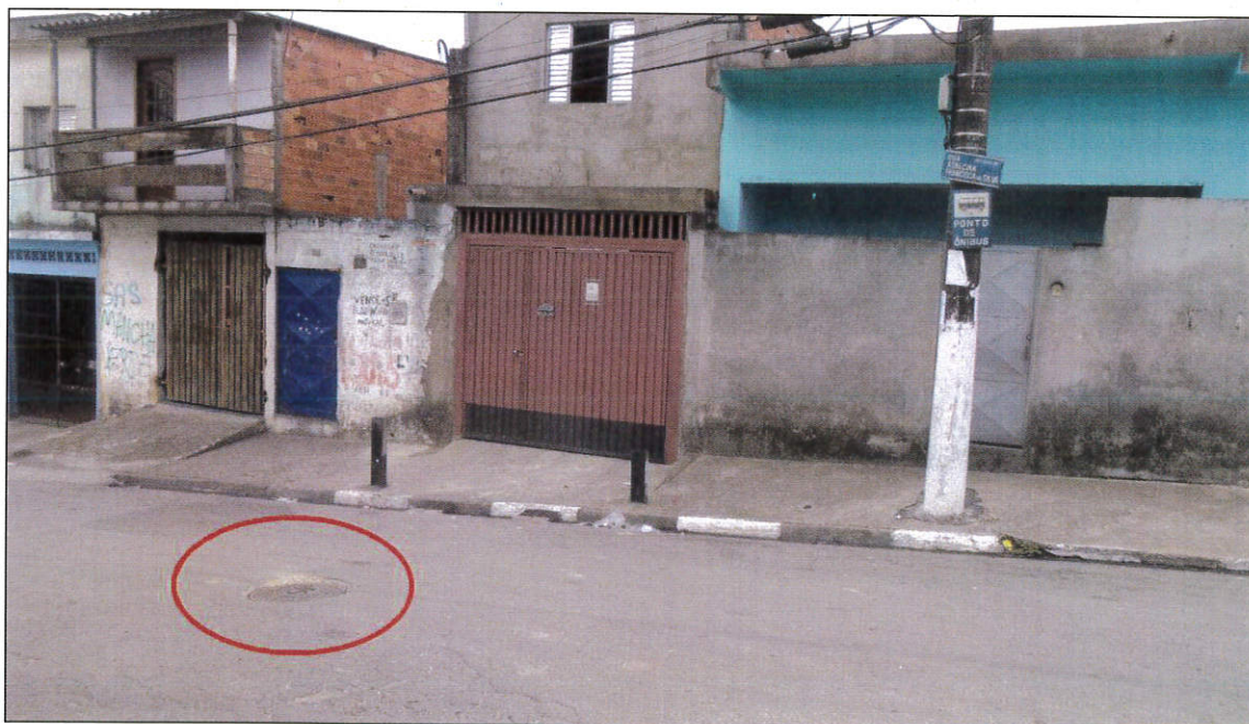
Foto 1: Poço de inspeção de esgoto da Rua Adalcina Francisca da Silva
