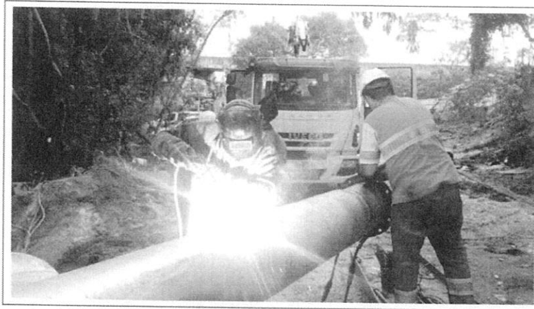
Figura 4 - Serviços de soldagem nova adutora de aço.
