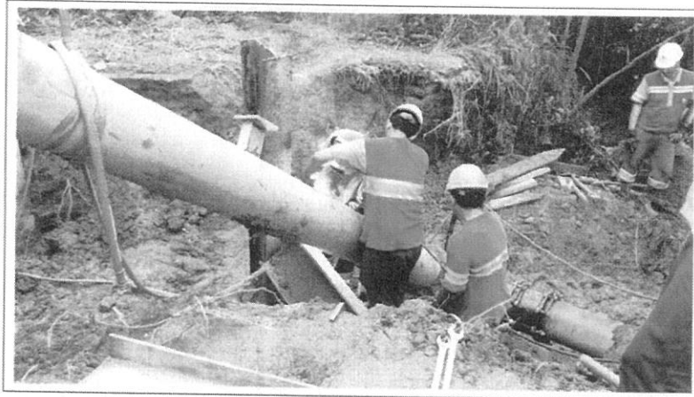
Figura 6 - Serviços de interligação.
