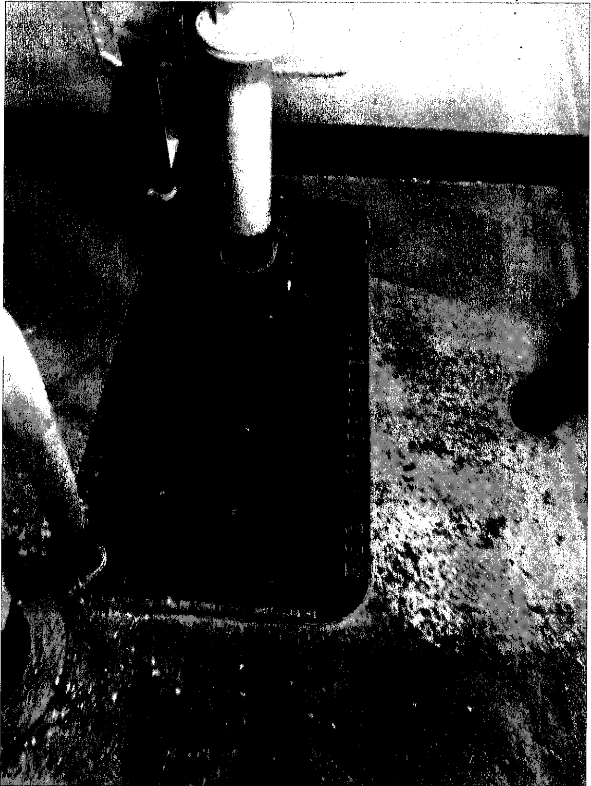
Figura 10 - Sistema de drenagem dos pisos da área interna do navio. Dentro da área gradeada encontra-se a bomba que macera e encaminha os resíduos ao Sewage Tank.
