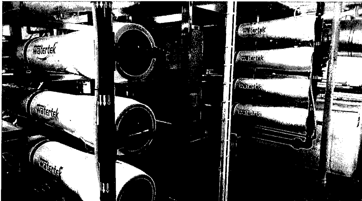
Figura 08 - Sistema de dessalinização de água, membranas para osmose reversa.
