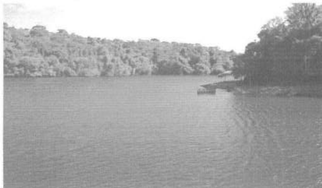
Figura 5 - Barragem no Reserva Florestal do Morro Grande
