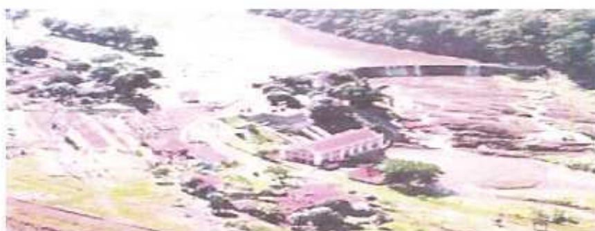
Imagem da Usina Após sua Construção Finalizada
