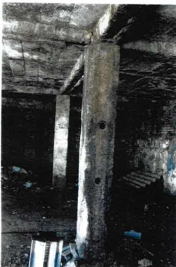
Foto 4 – Região da Edificação 3 após a extração de testemunhos no Pilar no nível do campo.
