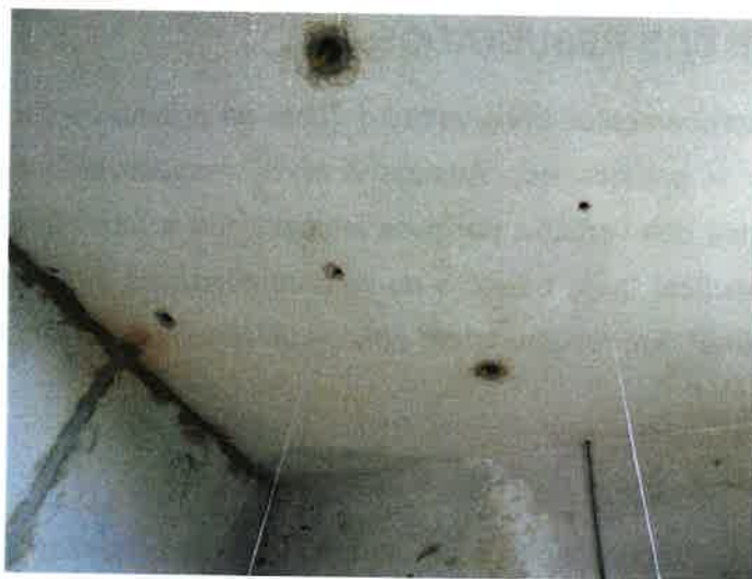
Figura 57 – Detalhe da furação da laje do sótão para passagem dos cabos da instrumentação para fixação nos patamares da arquibancada.
