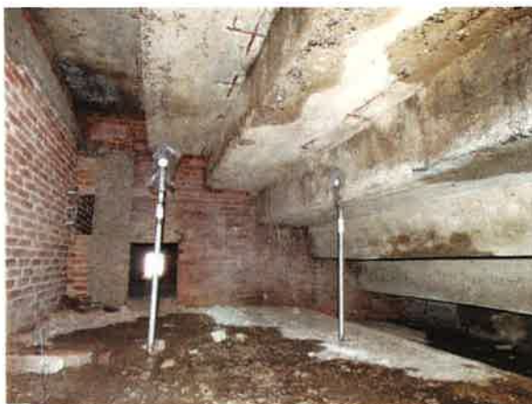
Figura 44 – Instrumentação instalada nos patamares da arquibancada.
