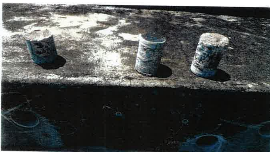
Foto 3 – Aspecto dos testemunhos de concreto da arquibancada da Edificação 5 (Eixo 20 a 21).
