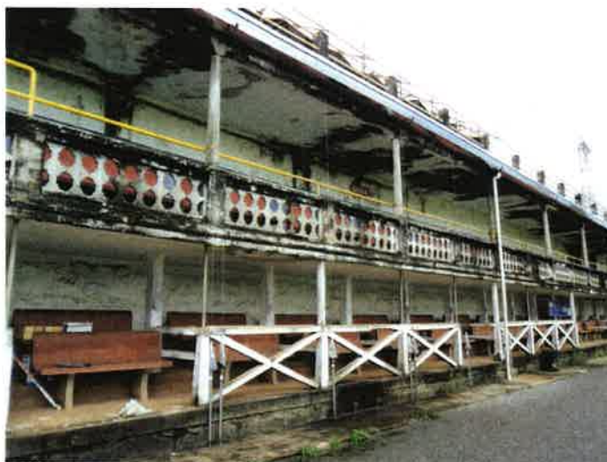
Figura 30 – Instrumentação instalada nas vigas de borda da região de "balanço" – Defletômetros D1 a D8.
