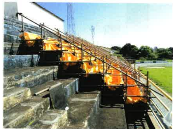
Figura 34 – Estrutura para prova de carga montada entre os eixos 12 e 14 da Edificação 2.
