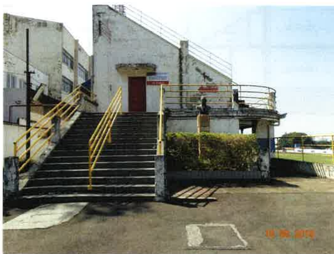
Figura 3 – Outra vista da Edificação 2 – Escada de acesso ao nível superior e arquibancadas.
