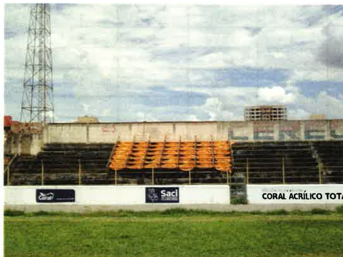
Figura 47 – Outra vista da estrutura para prova de carga montada entre os eixos 5 e 7 da Edificação 5.
