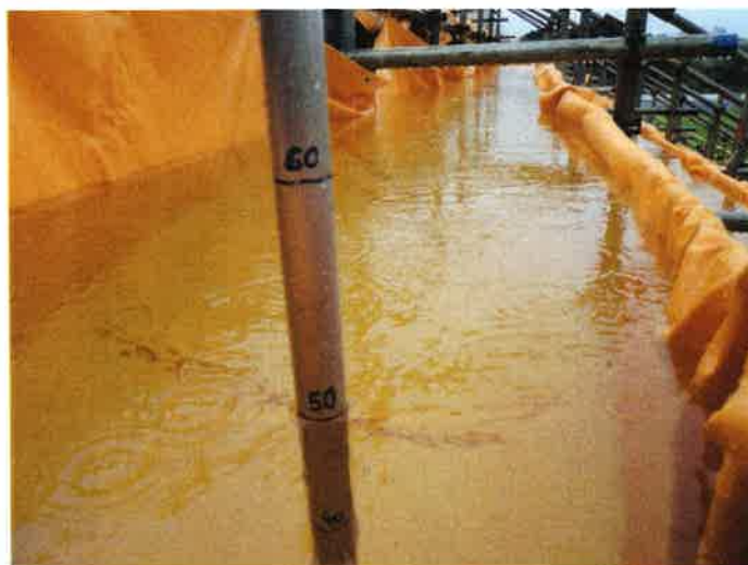
Figura 22 – Nível máximo de água aplicada na estrutura, correspondendo a um carregamento de 5\text{kN/m}^2 .
