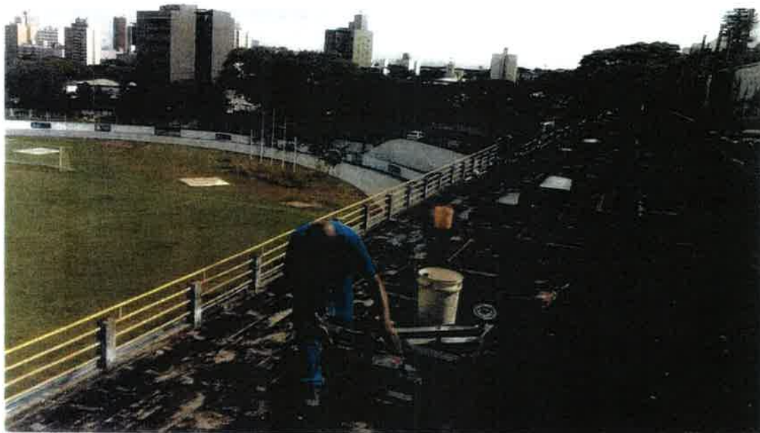
Foto 1 – Extração de testemunhos de concreto na arquibancada da Edificação 2.
