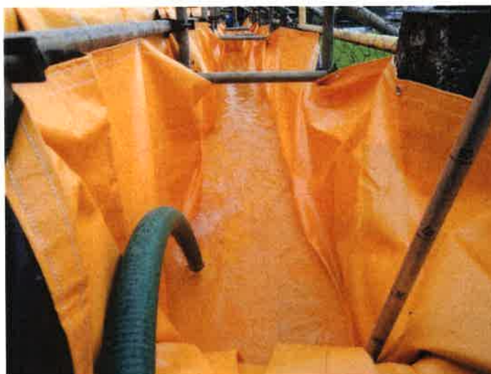
Figura 21 – Enchimento dos reservatórios com água.
