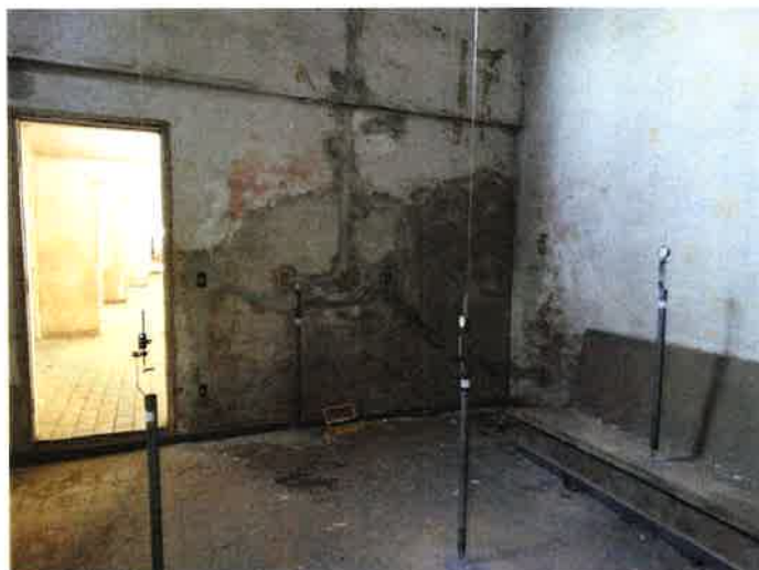
Figura 56 – Instrumentação instalada nas arquibancadas.
