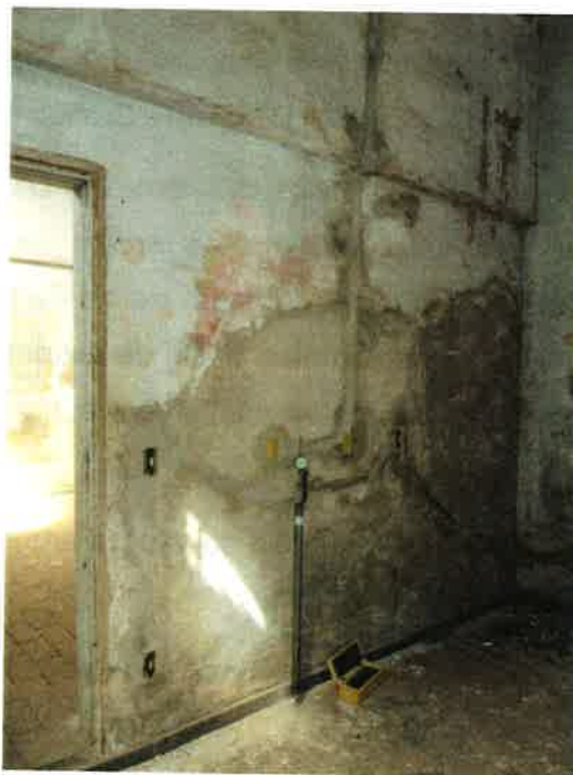
Figura 58 – Instrumentação instalada na viga localizada sobre a parede.
