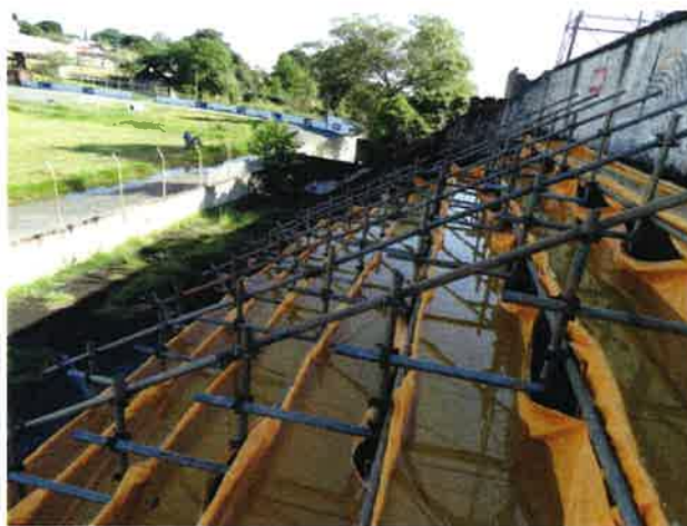
Figura 49 – Reservatórios preenchidos totalmente com água, correspondendo ao carregamento máximo aplicado na arquibancada.
