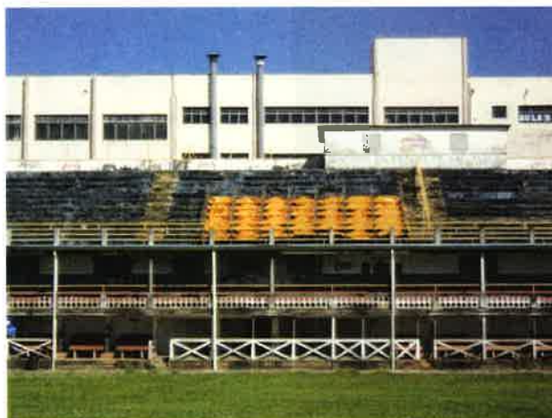
Figura 35 – Outra vista da estrutura para prova de carga montada entre os eixos 12 e 14.
