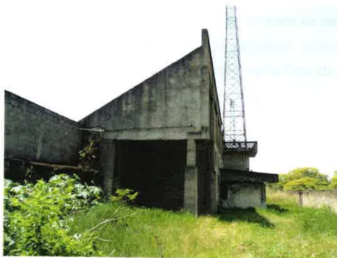
Figura 8 – Região dos fundos da Edificação 5 – Vista do nível sob as arquibancadas destinado aos alojamentos.
