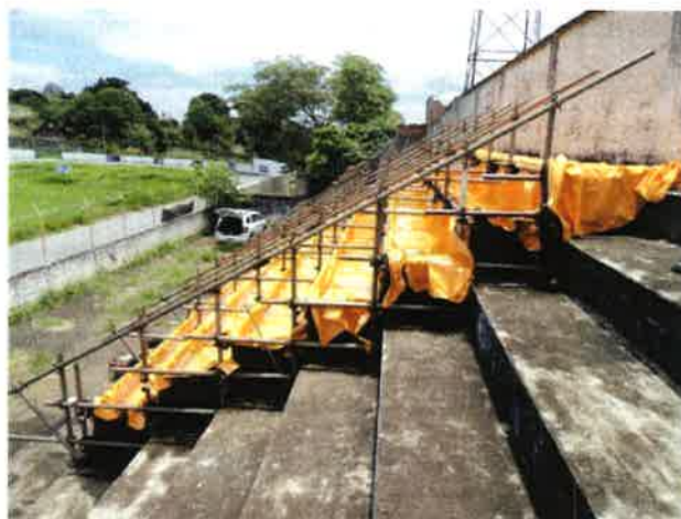
Figura 46 – Estrutura para prova de carga montada entre os eixos 5 e 7 da Edificação 5.
