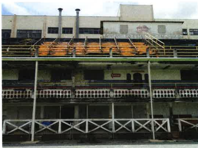
Figura 43 – Instrumentação instalada nas vigas de borda da região de “balanço” – Defletômetros D1 a D6.
