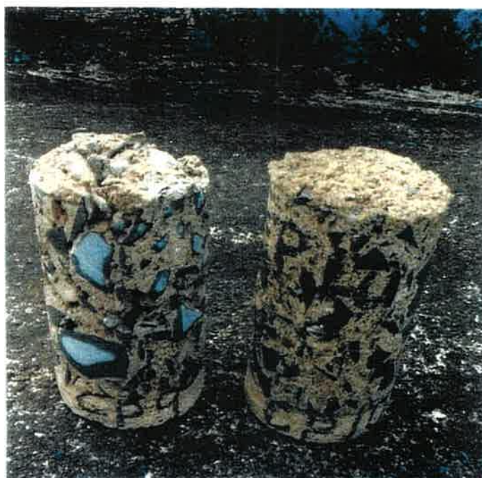
Foto 2 – Aspecto dos testemunhos de concreto da arquibancada da Edificação 2 (Eixo 12 a 13)
