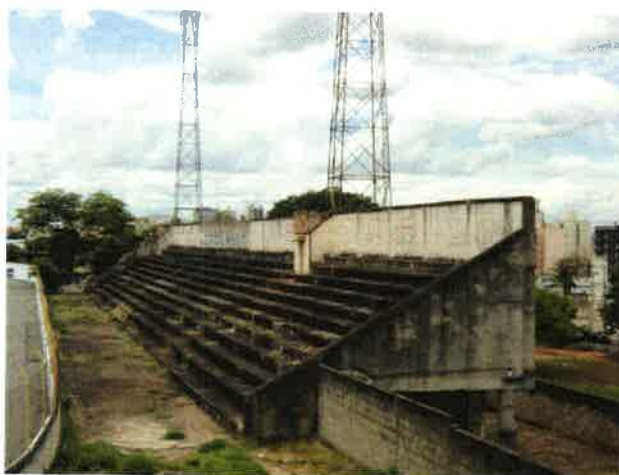
Figura 7 – Edificação 5 – Vista das arquibancadas.
