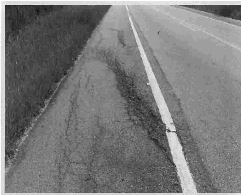
Foto 20 – SP 123 – Km 20,600m – Sentido Norte.
