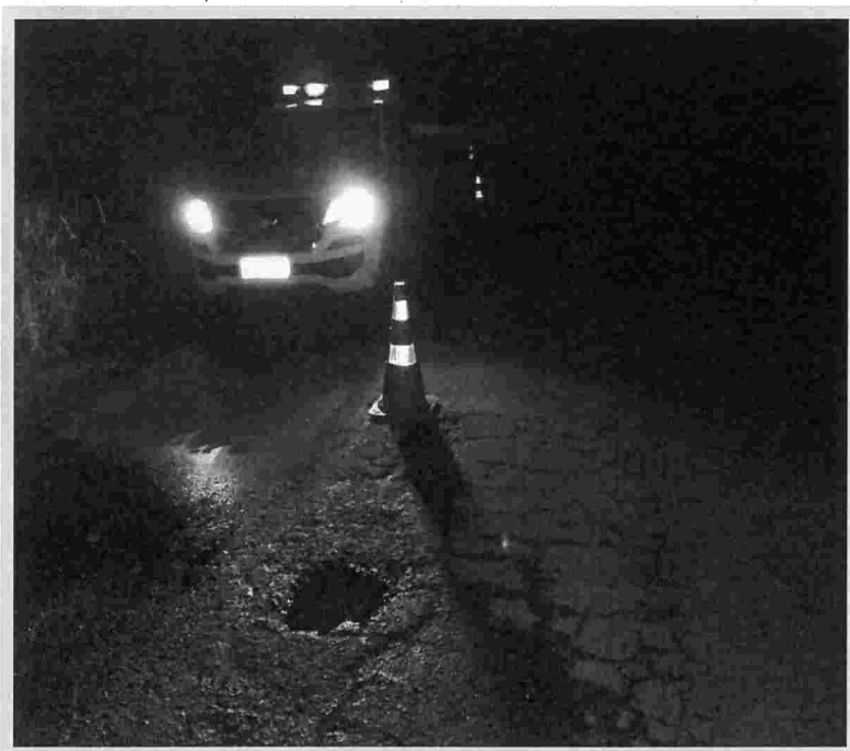
Foto 36 – SP 125 – Km 36,800m – Sentido Norte.
