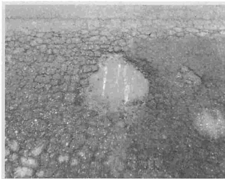
Foto 18 – SP 123 – Km 35,800m – Sentido Norte.
