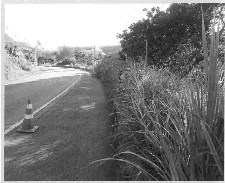
Foto 25 – SP 125 – Km 49,500m – Sentido Norte.
