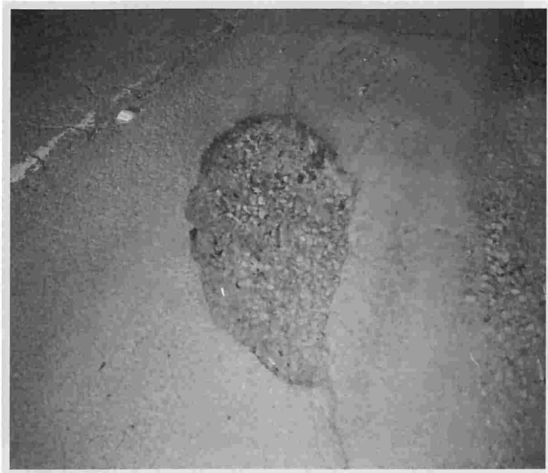
Foto 09 – SP 062 – Km 138,600m – Sentido Oeste.
