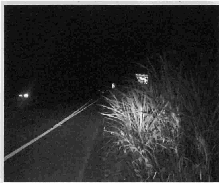
Foto 14 – SP 123 – Km 6,050m – Sentido Norte.
