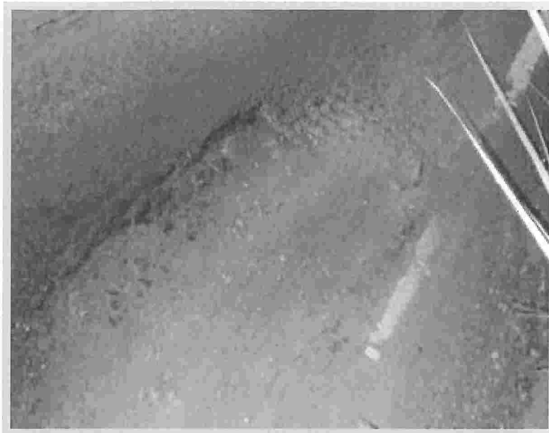
Foto 17 – SP 123 – Km 31,300m – Sentido Norte.
