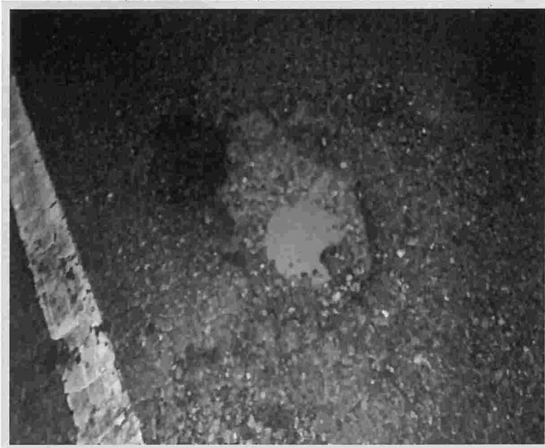
Foto 24 – SPA 017/123 – Km 2,100m – Sentido Norte.
