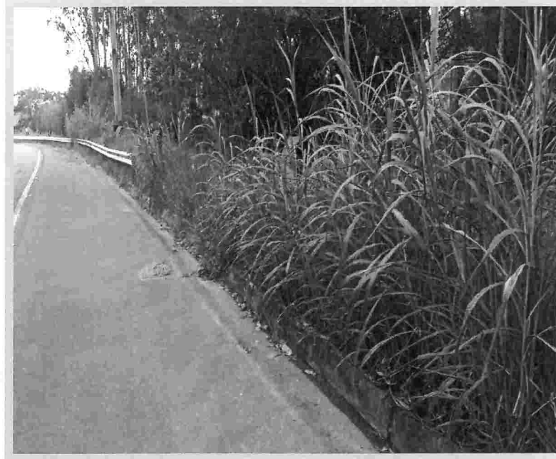
Foto 27 – SP 125 – Km 51,100m – Sentido Norte.
