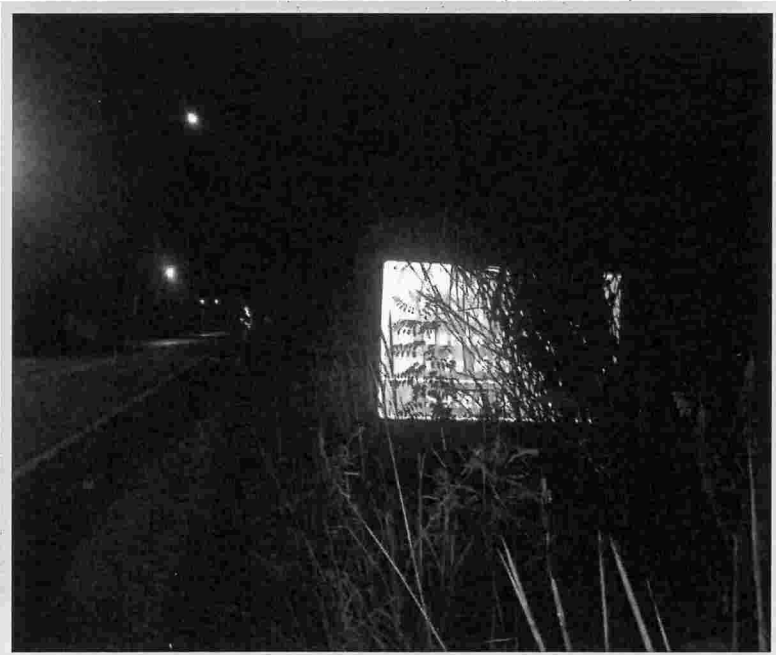
Foto 22 – SPA 017.123 – Km 4,500m – Sentido Norte.
