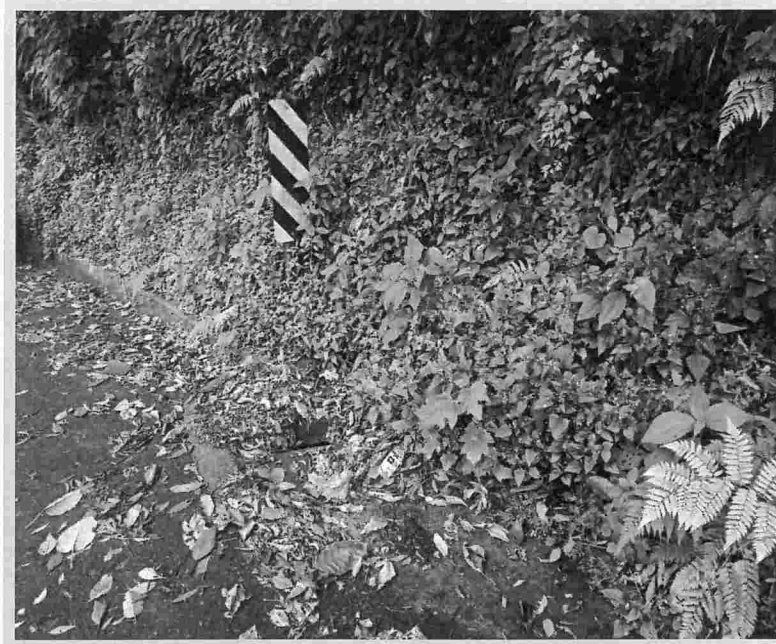
Foto 31 – SP 125 – Km 84,200m – Sentido Sul.
