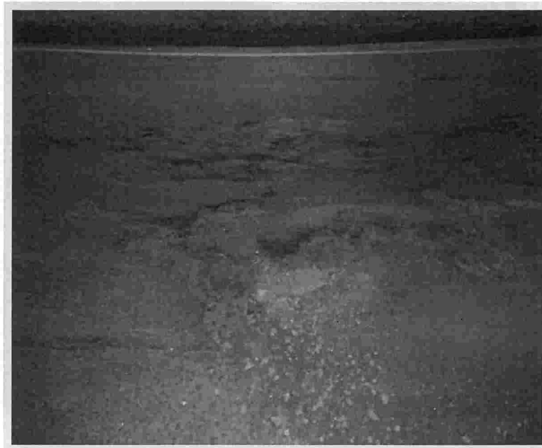
Foto 06 – SP 062 – Km 155,600m – Sentido Oeste.
