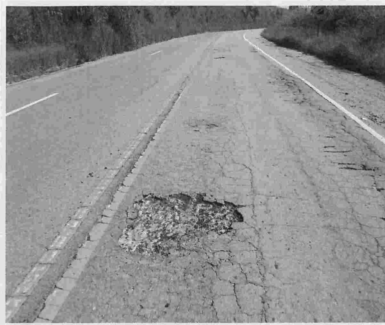
Foto 39 – SP 125 – Km 31,550m – Sentido Norte.
