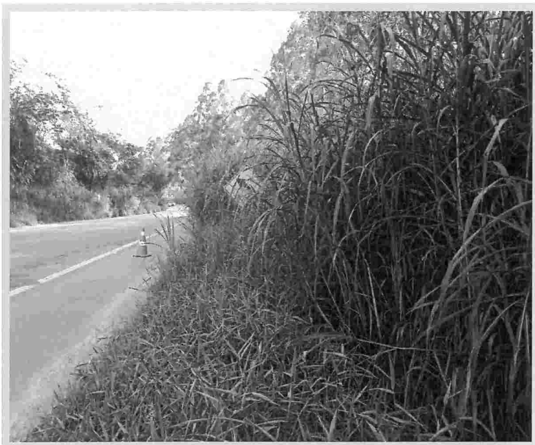
Foto 26 – SP 125 – Km 19,100m – Sentido Norte.
