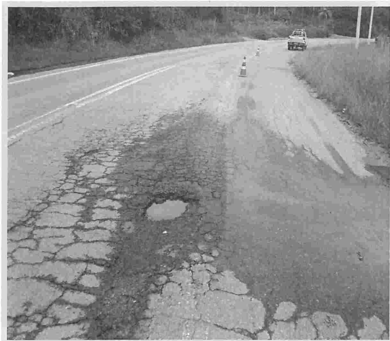
Foto 37 – SP 125 – Km 36,900m – Sentido Norte.
