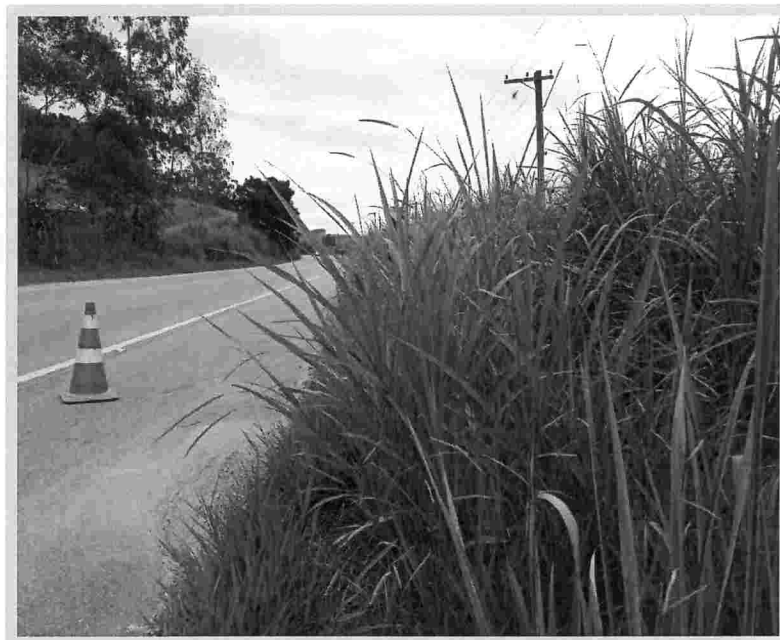
Foto 28 – SP 125 – Km 16,700m – Sentido Norte.
