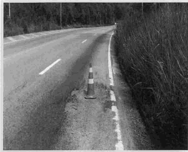
Foto 19 – SP 123 – Km 31,250m – Sentido Norte.
