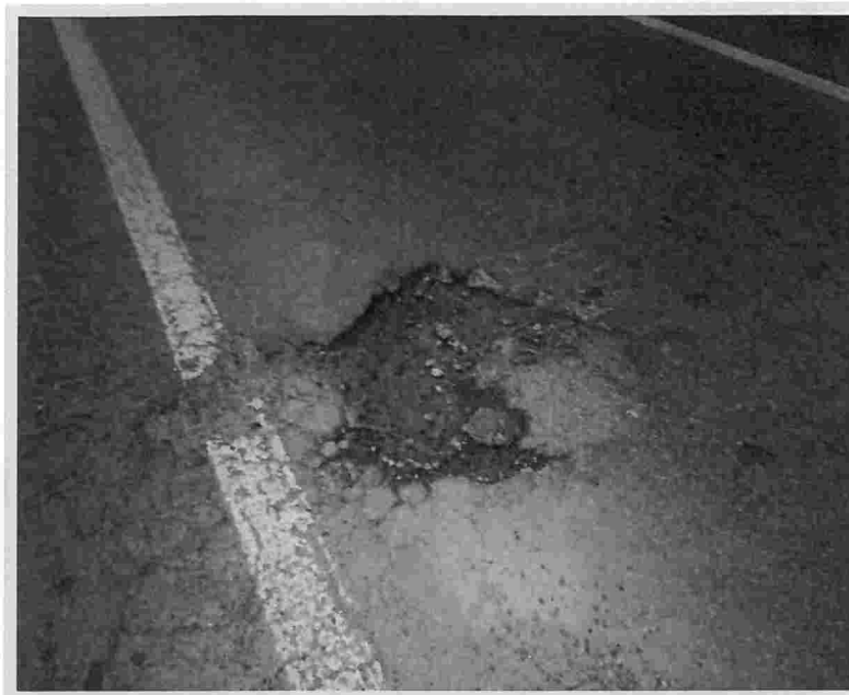
Foto 07 – SP 062 – Km 158,900m – Sentido Oeste.
