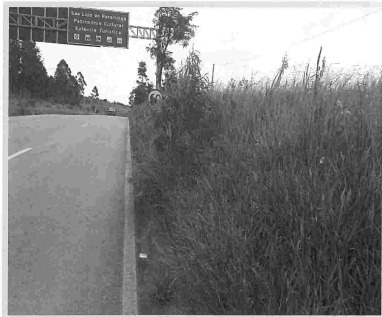
Foto 29 – SP 125 – Km 31,900m – Sentido Norte.
