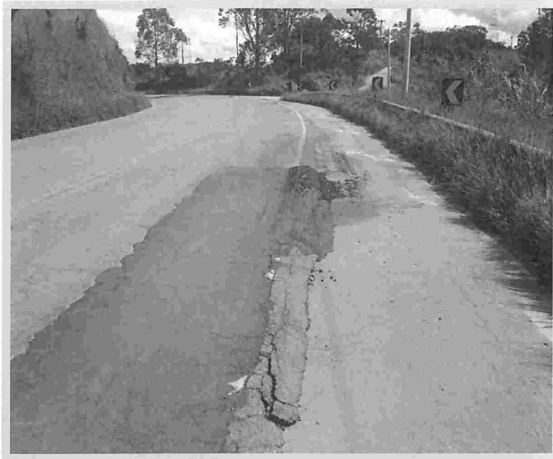
Foto 33 – SP 125 – Km 31,450m – Sentido Norte.
