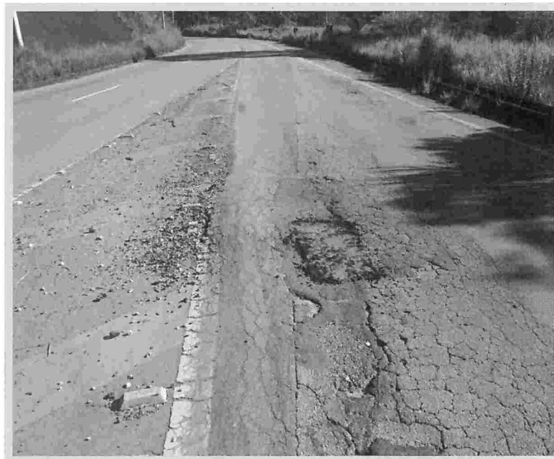
Foto 32 – SP 125 – Km 25,700m – Sentido Norte.
