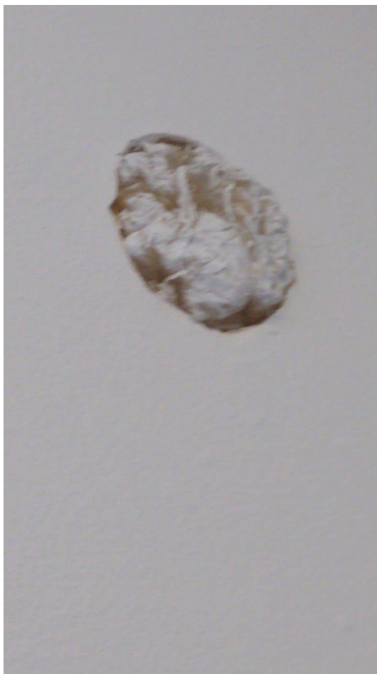
Parede com furos
