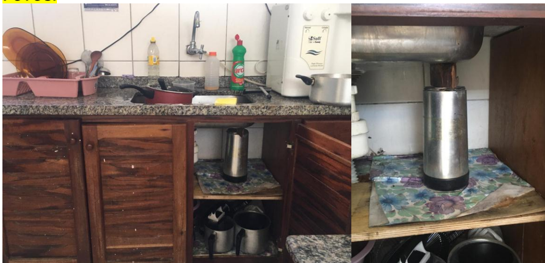
Gabinete de pia segurado por garrada térmica
