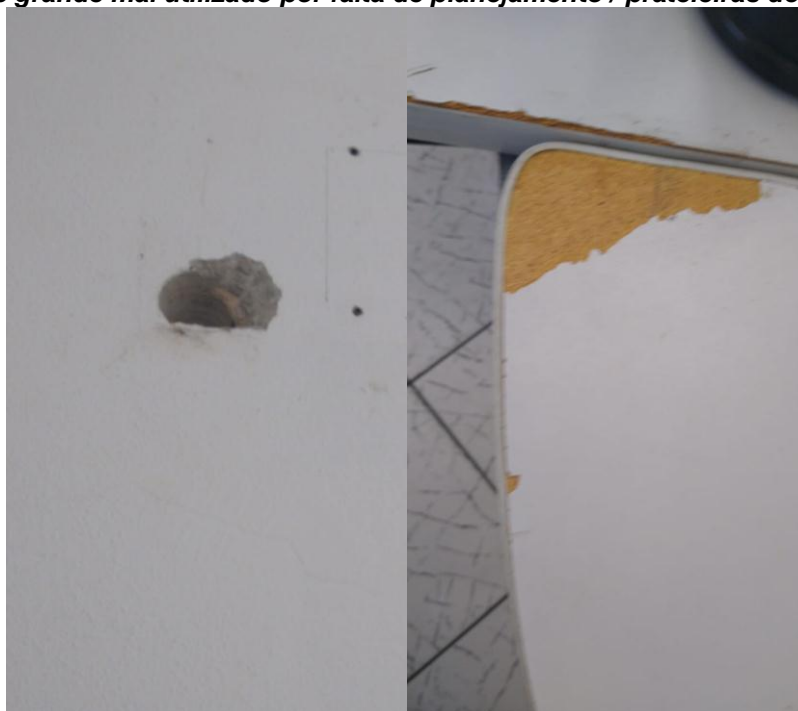
Parede com furos
