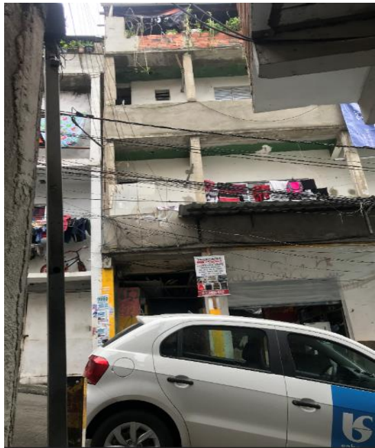
Habitação Irregular – 5 pavimentos e sem caixa d'água
