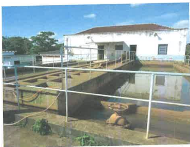
FIG. 049 – ETA Estação Tratamento de Água de Ipuã
