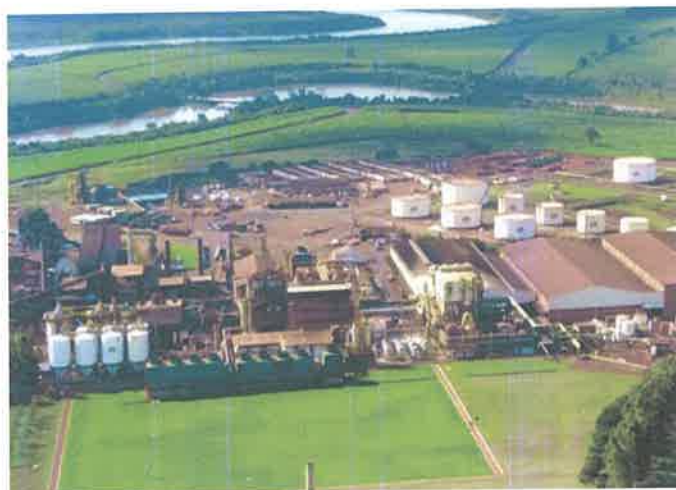
FIG 003 – AEREA DA USINA ALTA MOGIANA – FONTE – ALTA MOGIANA
