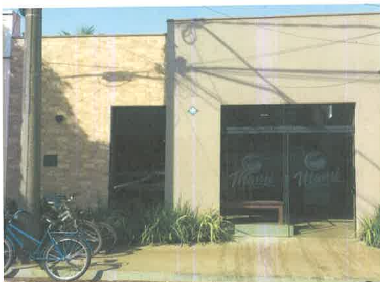
FIG. 025 FACHADA DA MAMI – FONTE PMI
