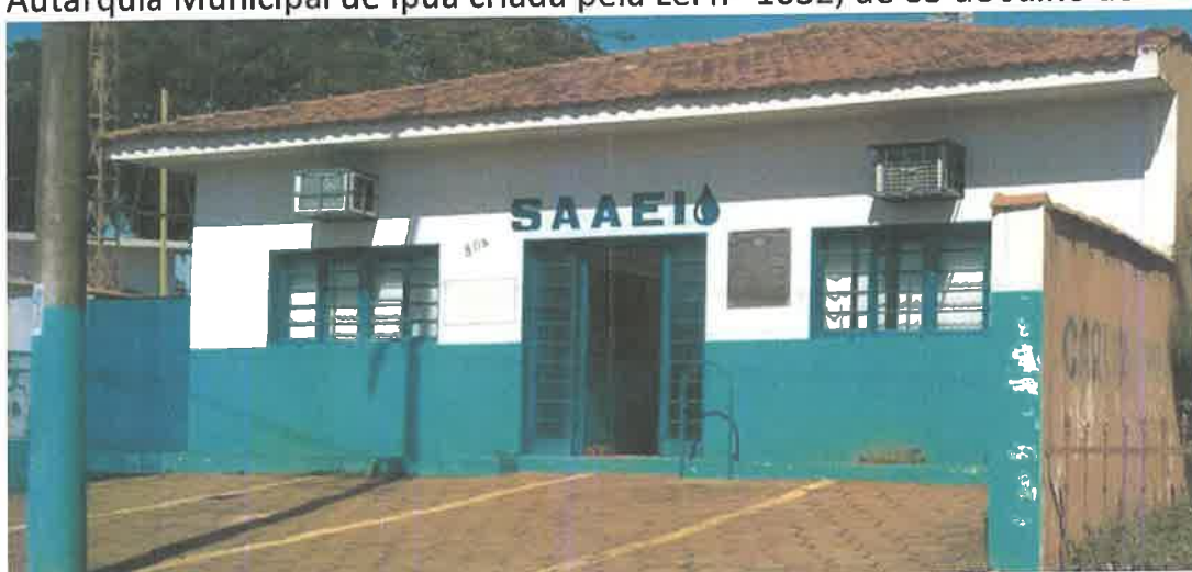
Fig. 088 fachada do SAAEI – FONTE PMI
