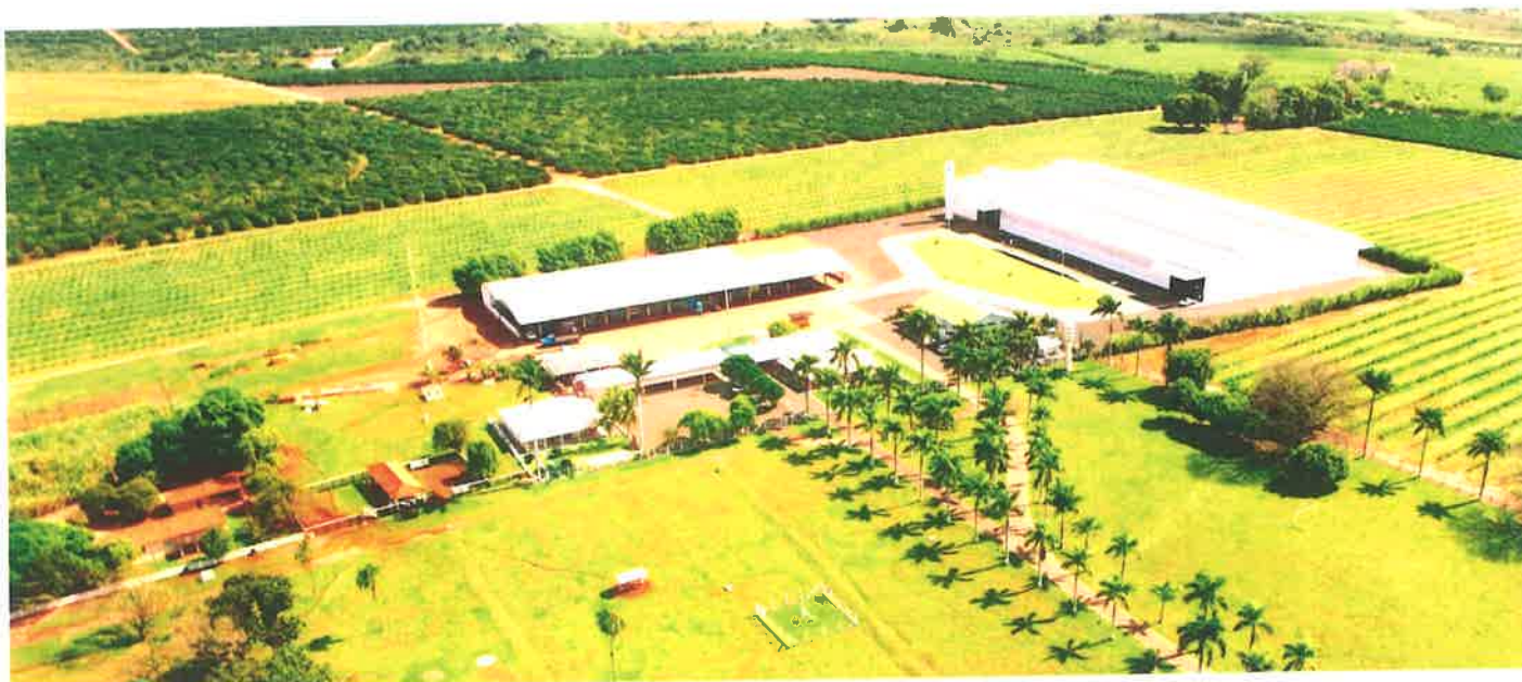
Instalações da Fazenda Costa Mello, em Paranapuã (SP).
