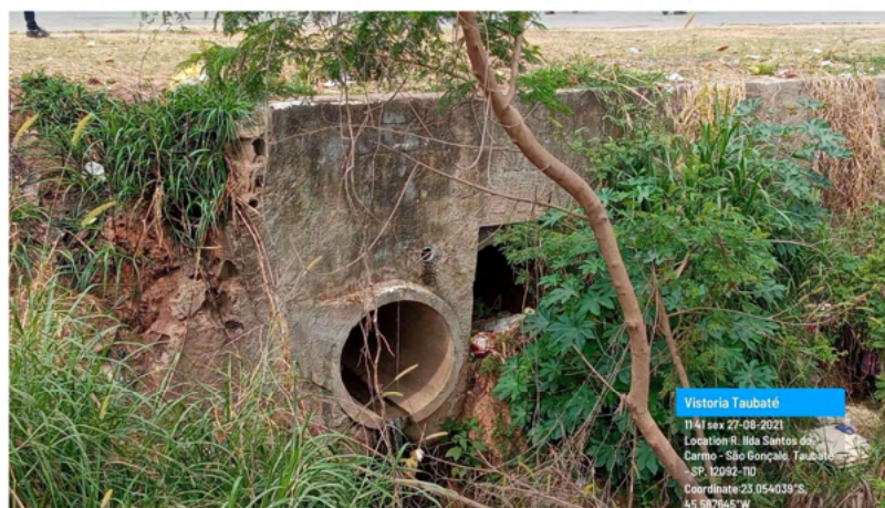
Figura 8. Vista do desemboque da travessia
