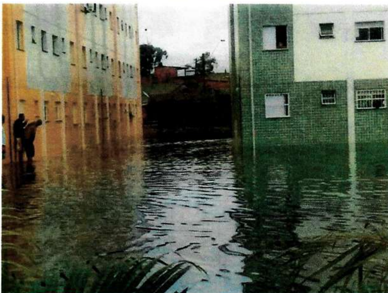
Imagens dos condomínios inundados durante a enchente ocorrida em Março de 2018 na cidade de São Vicente.
