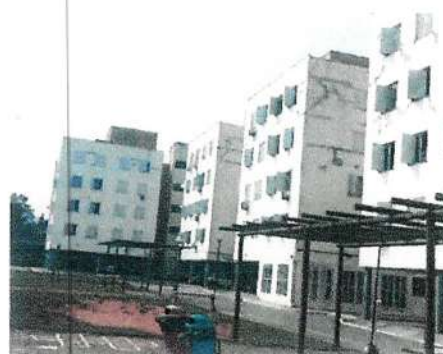
Foto 24 – Lote 3: Vista interna das fachadas dos Blocos C e D.
