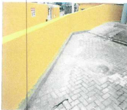
Foto 35 – Lote 3: Recuperação da mureta da rampa
