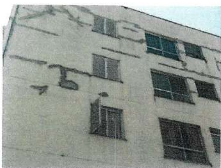
Foto 25 – Lote 3: Vista da fachada lateral direita do Bloco A
