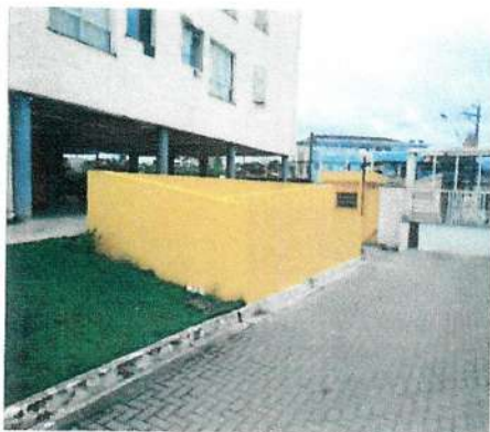
Foto 34 – Lote 3: Recuperação da rampa vista interna do condomínio
