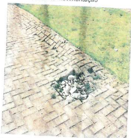
Foto 30 – Lote 3: Movimentação do piso intertravado
