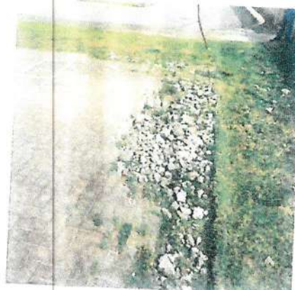
Foto 29 – Lote 3: Bloco intertravado solto nas bordas laterais
