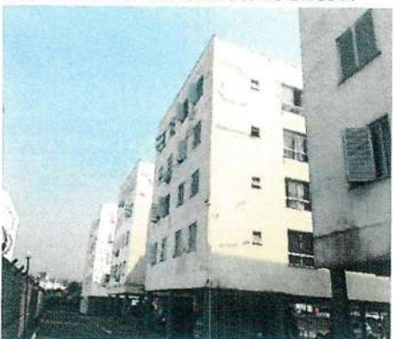
Foto 27 – Lote 3: Vista da fachada lateral esquerda dos Blocos A e B
