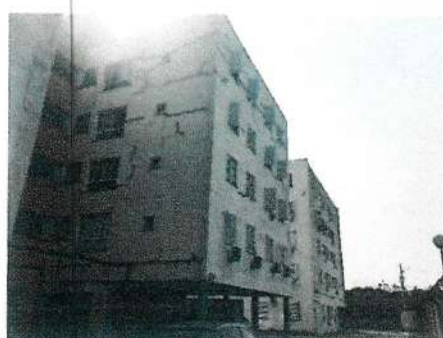
Foto 26 – Lote 3: Vista da fachada lateral direita do Bloco C
