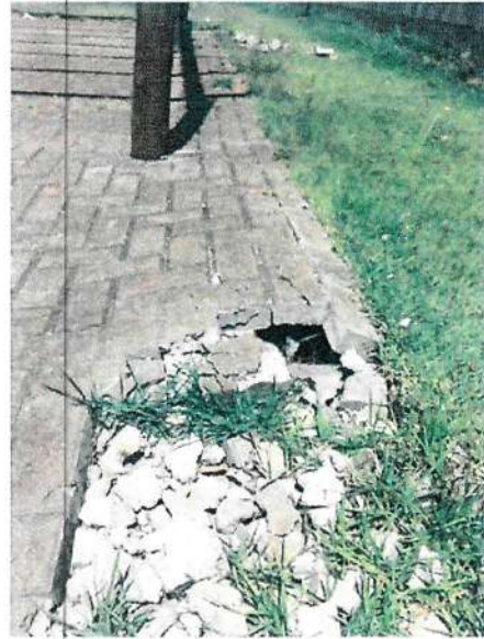
Piso do Playground em foto de hoje com pavimento levantando e peças danificadas pela deformação.
