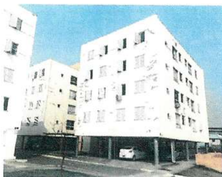
Foto 23 – Lote 3: Vista interna da fachada do Bloco A
