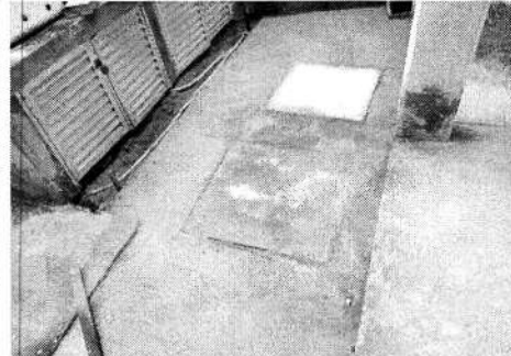
Foto 06: Execução das caixas de esgoto e tampas
