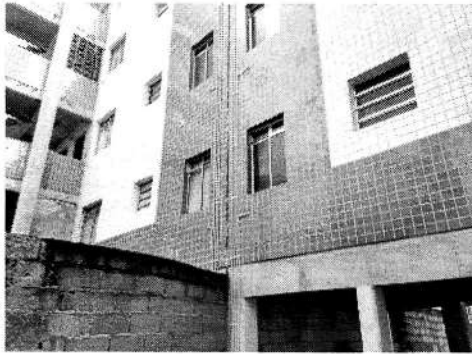
Foto 11 – Vista da rede de gás
