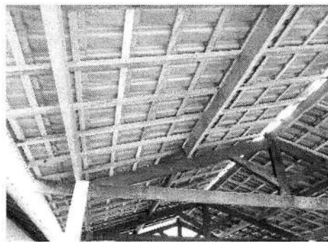
Foto 07 – Substituição do madeiramento CAC
