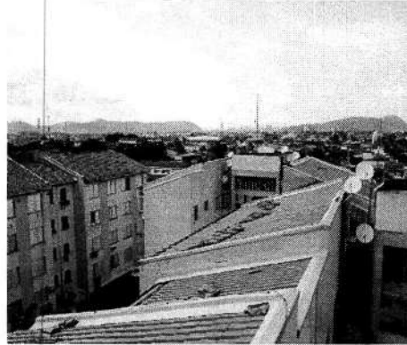
Foto 10 – Substituição dos rufos
