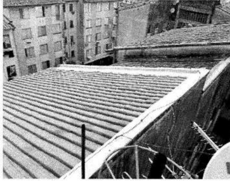
Foto 09 – Revitalização do Telhado
