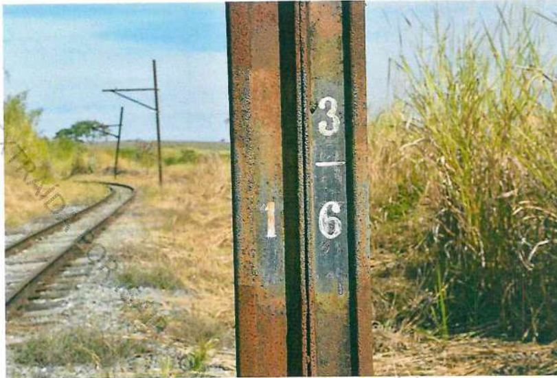
Foto 10. Imagem em detalhe do poste 16 do km 03.
