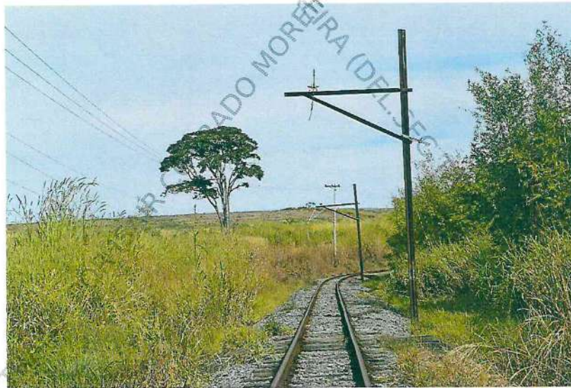
Foto 11. Imagem geral do poste 17 do km 03.
