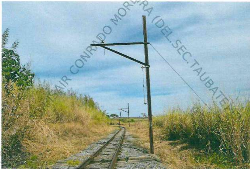
Foto 9. Imagem geral do poste 16 do km.03.
