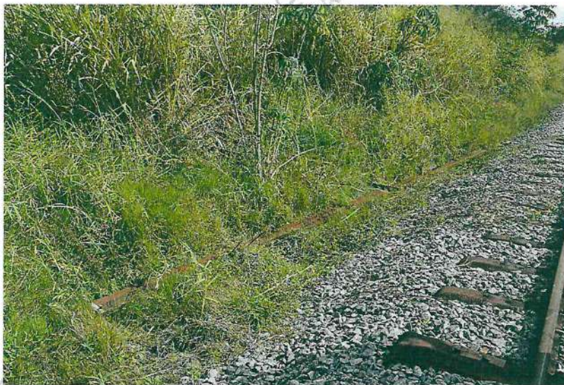
Foto 24. Imagem de onde e como encontrado o poste nº 23 do km 05.
