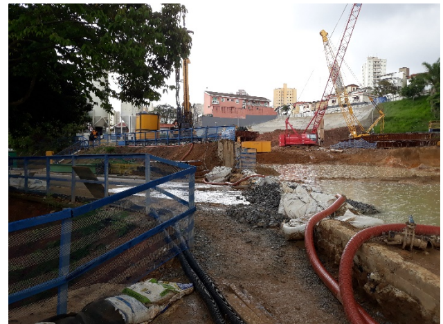
Figuras 6 e 7: Muro guia da escavação da vala (à direita) e sacarias utilizadas como barreira física para conter
