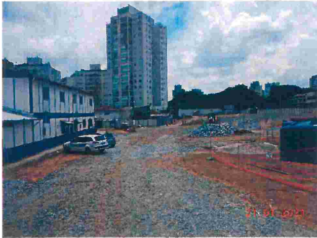
Figura 14: Canteiro de obras da futura estação Vila Formosa (Lote 1).
