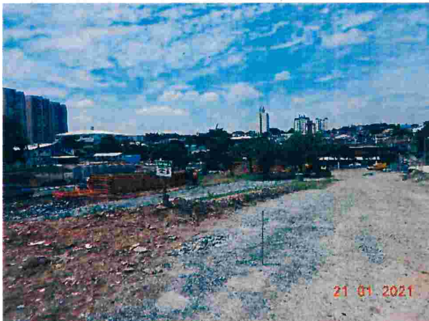
Figura 6: Canteiro de obras para implantação da estação Anália Franco - Área 1 (Lote 4).
