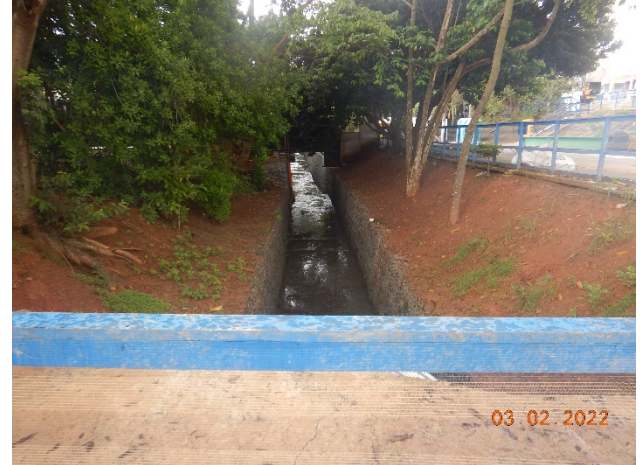
Figura 3: Córrego Rapadura no interior da obra.
