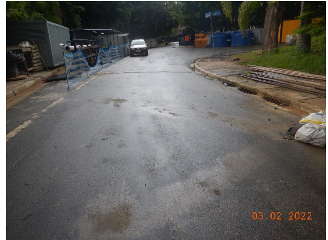
Figuras 4 e 5: Sacarias são utilizadas para conter sedimentos carregados pelas águas pluviais.
