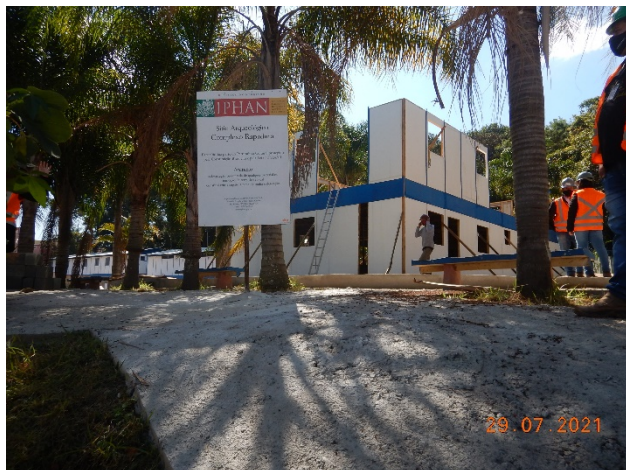
Figura 12: Radier sobre sítio arqueológico na Pça Mauro Broco, interno à área de intervenção da obra, cujo projeto foi aprovado pelo IPHAN.
