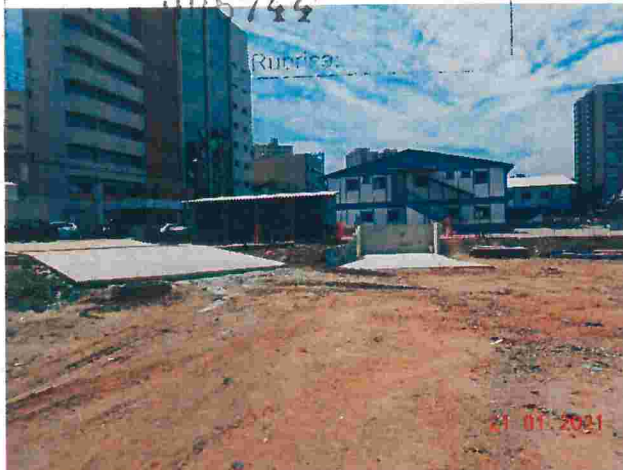
Figura 9: Canteiro de obras para implantação da estação Anália Franco - Área 4 (Lote 4).
