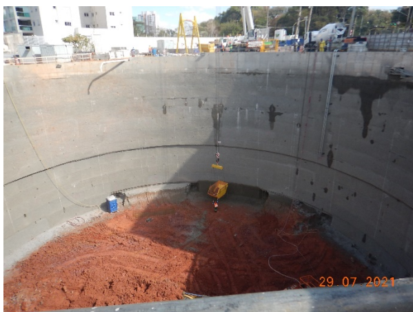
Figura 8: Escavação do poço da estação Vila Formosa.
