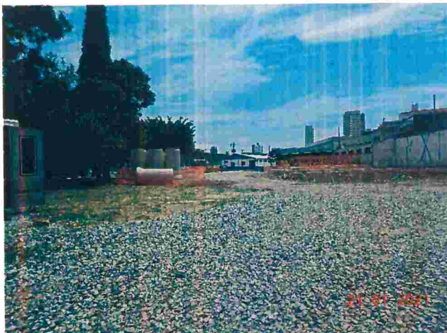
Figura 8: Canteiro de obras para implantação da estação Anália Franco - Área 3 (Lote 4).
