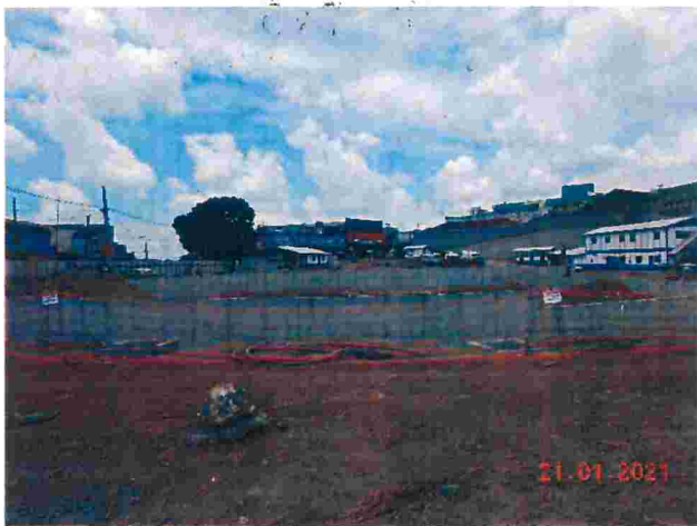
Figuras 16 e 17: Construção do muro guia da escavação do poço da estação Vila Formosa (Lote 1).
