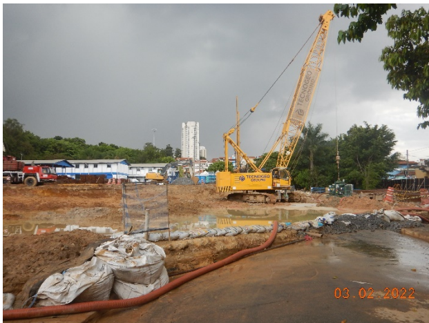
Figuras 6 e 7: Muro guia da escavação da vala (à direita) e sacarias utilizadas como barreira física para conter
