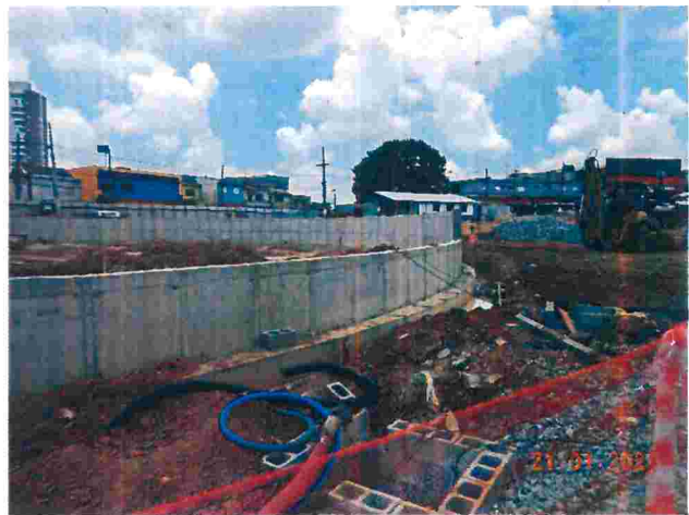
Figuras 16 e 17: Construção do muro guia da escavação do poço da estação Vila Formosa (Lote 1).
