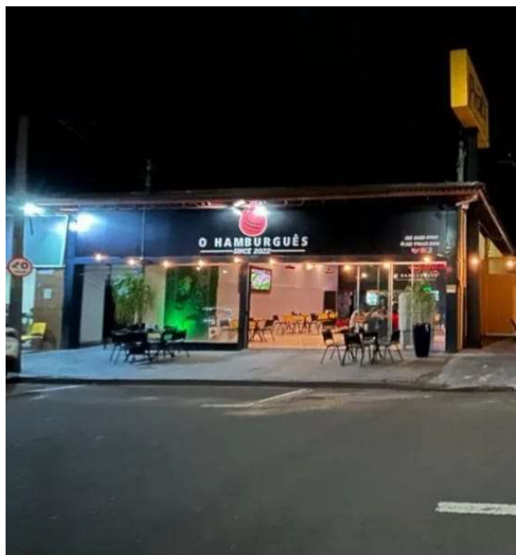
Figura 110 – O Hamburguês – Fachada
