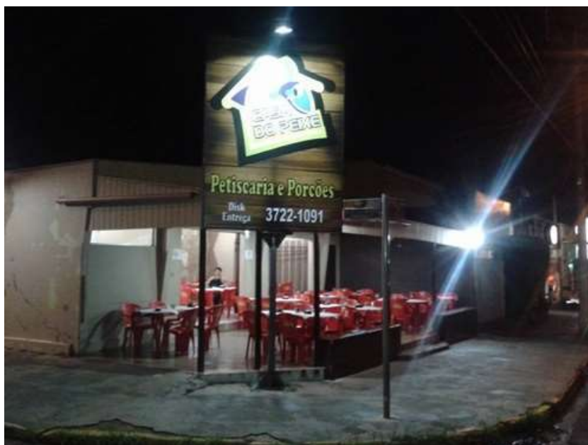
Figura 85 - Casa Do Peixe - Fachada
