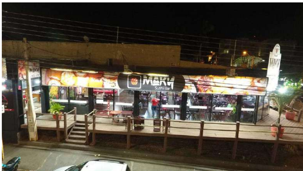
Figura 53 - Maky Sushi Bar - Fachada
