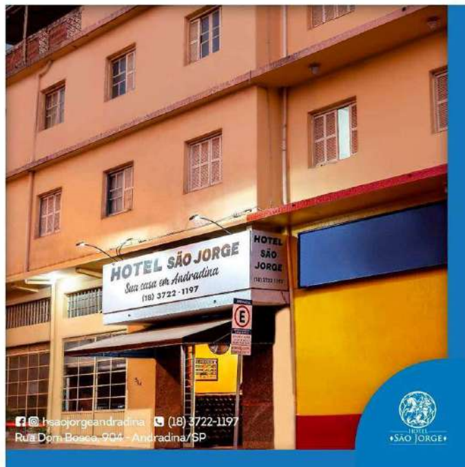
Figura 13 - Hotel São Jorge - Fachada
