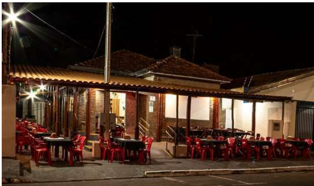
Figura 68 – Casarão Pizzaria E Restaurante – Fachada
