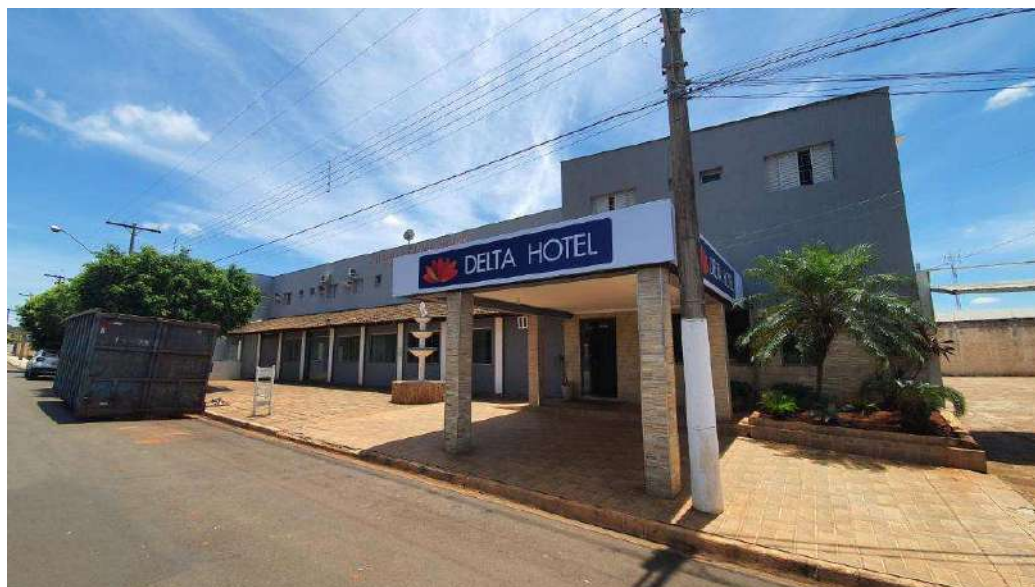
Figura 15 – Delta Hotel - Fachada
