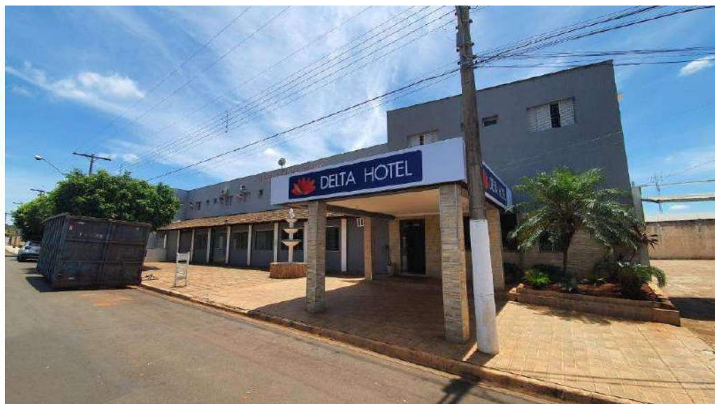
Figura 67 – Delta Hotel - Fachada
