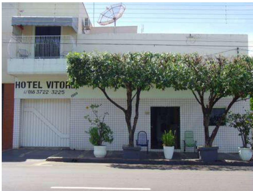
Figura 55 - Hotel Vitoria - Fachada
