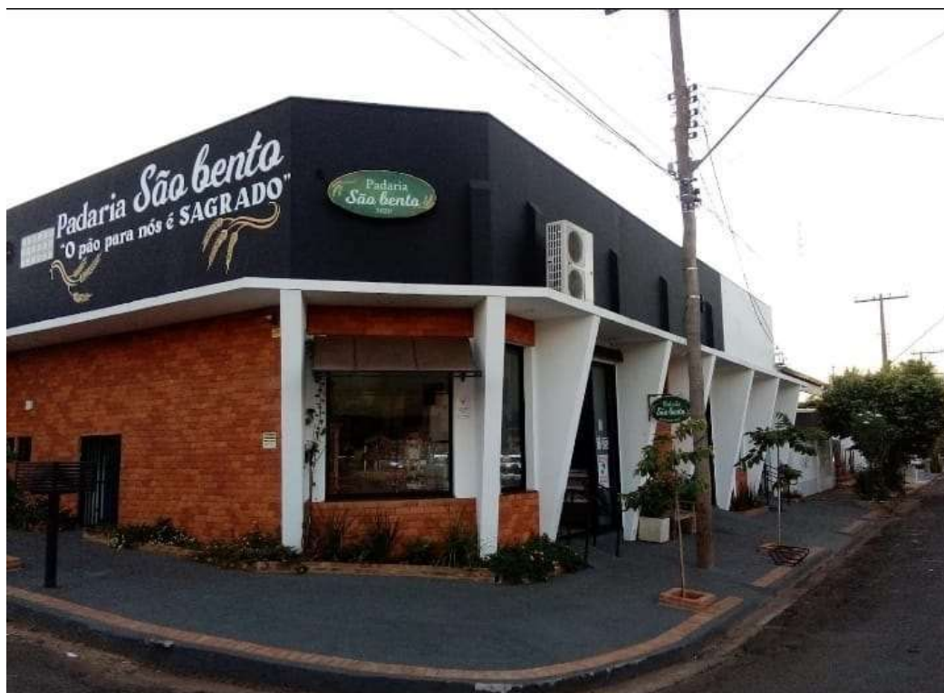
Figura 112 – Panificadora São Bento - Fachada
