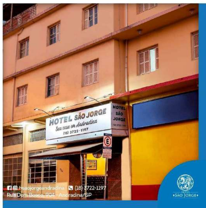
Figura 65 - Hotel São Jorge - Fachada
