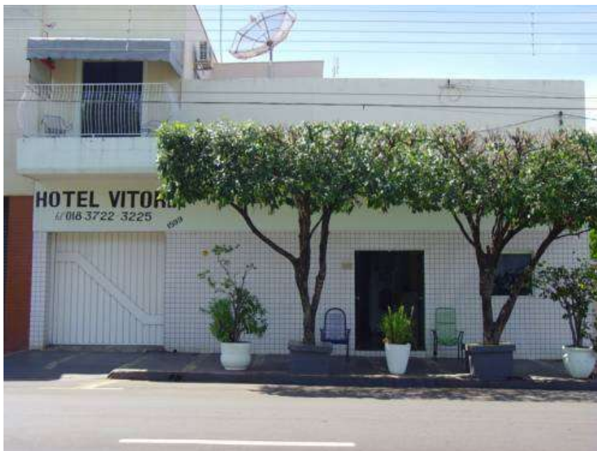
Figura 3 - Hotel Vitoria - Fachada
