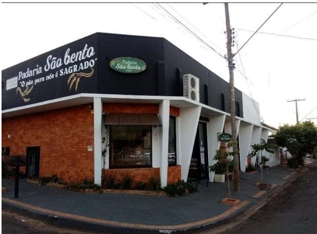
Figura 66 – Panificadora São Bento - Fachada
