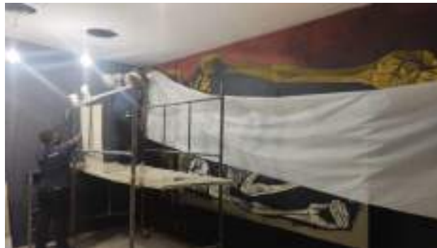
Figura 3 – Acondicionamento das obras
