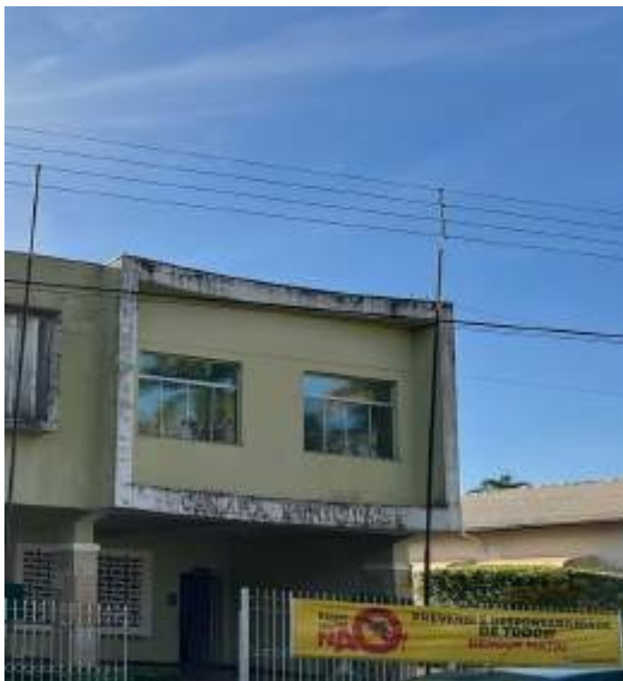
Figura 8 – Fachada Câmara Municipal de Gália
