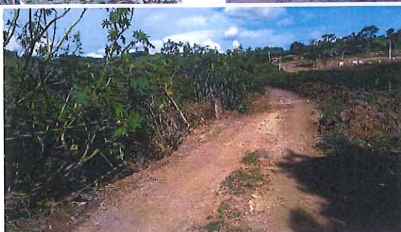
Imagens 22, 23 e 24: Duas Pontes da Estrada Municipal Elias de Oliveira parcialmente afetada.
