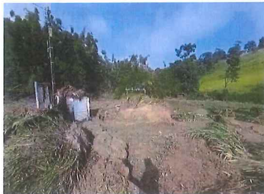
Imagem 2: Poço de abastecimento situado no Bairro do Arraial
