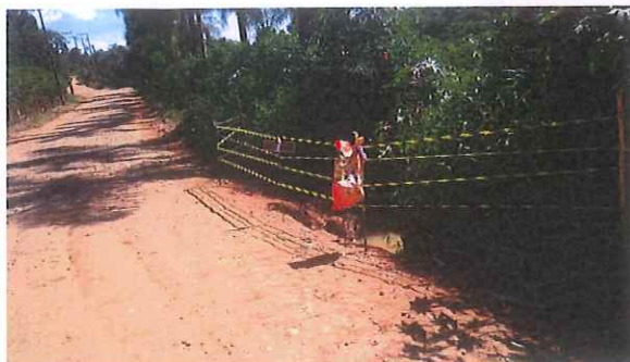
Imagens 25: Ponte da Estrada Municipal Natalim de Lima Jardim parcialmente afetada.
