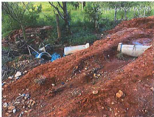
Imagem 3 e 4: Obstrução galerias pluviais por lama
