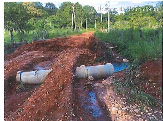
Imagem 3 e 4: Obstrução galerias pluviais por lama
