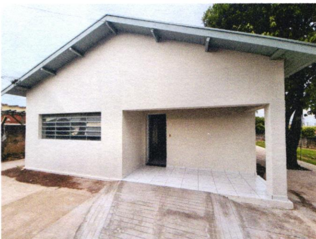
Foto da fachada Principal aguardando autorização para inserir a pintura do nome do Imóvel.
