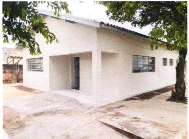
Foto do Imóvel após a reforma de adequação
