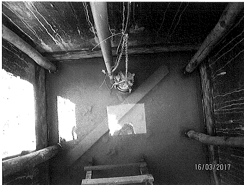
Foto 4 – Vista interna do poço de sucção em construção
