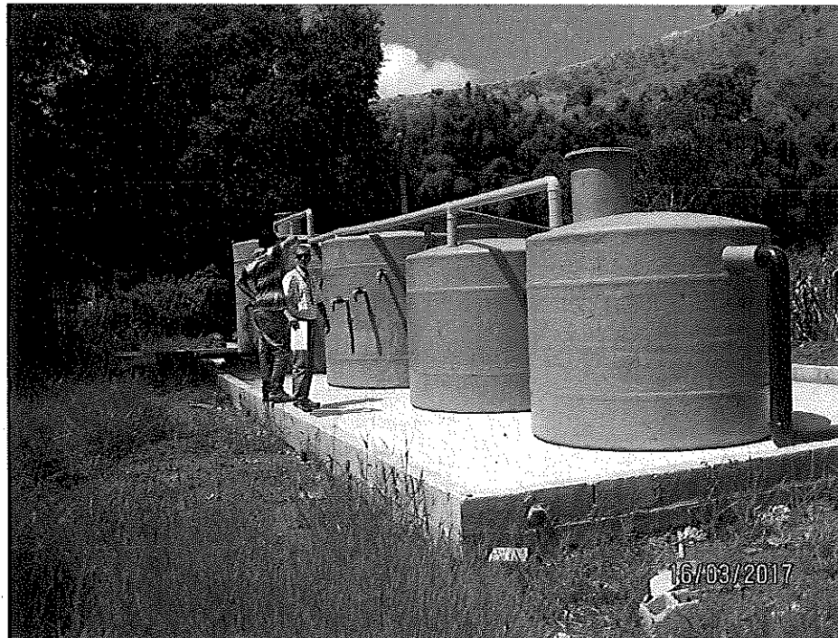
Foto 6 – Vista lateral das unidades que funcionarão como reatores UASB e tanques de aerção
