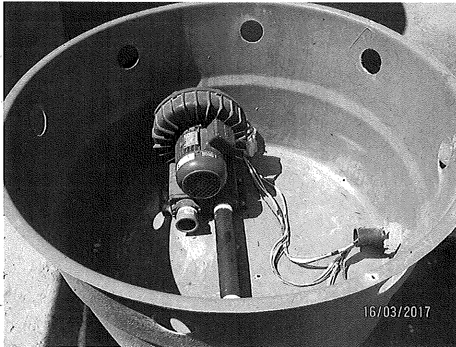
Foto 8 – Detalhe da instalação de compressor
