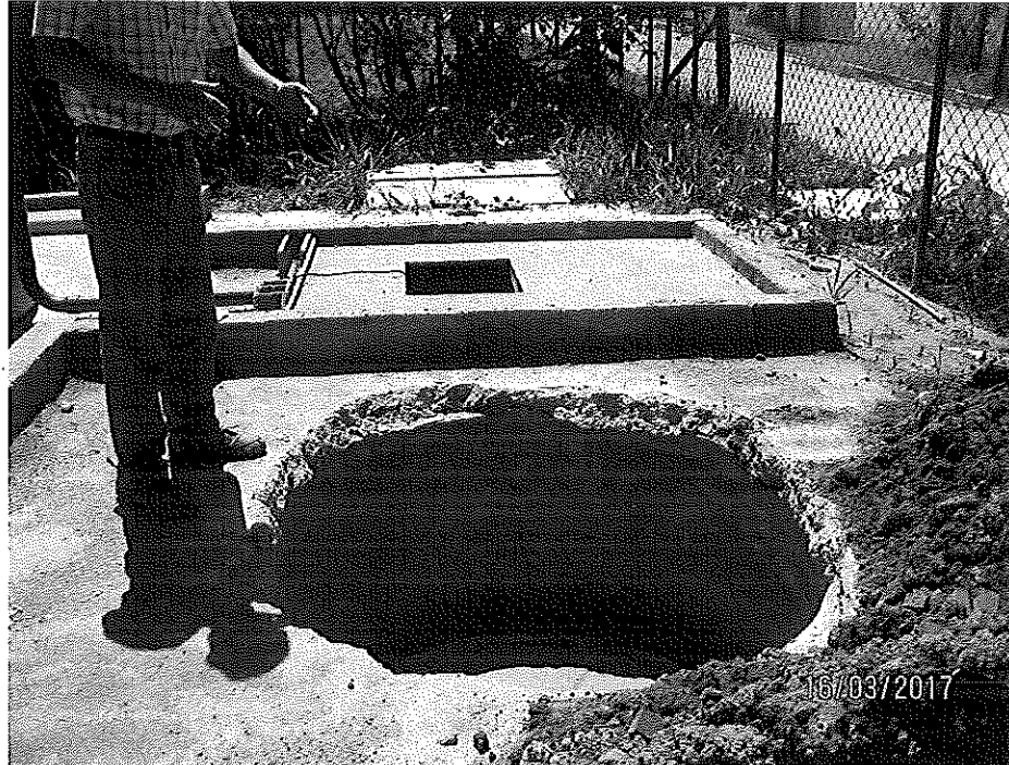
Foto 3 – Vista externa da construção do poço pulmão, em primeiro plano, e do poço de sucção, ao fundo.
