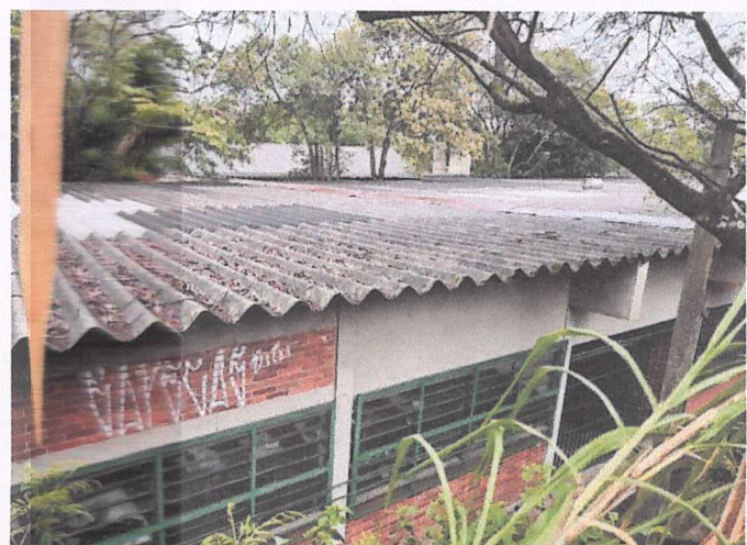
Substituição das telhas onduladas em fibrocimento
