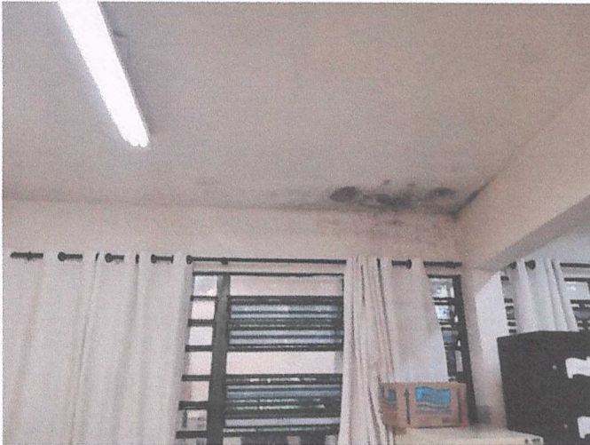
Pintura das areas afetadas pela intervenção
