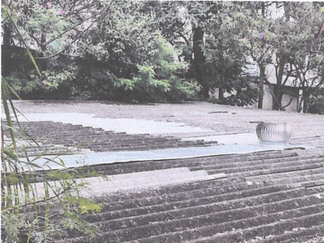
Substituição das telhas onduladas em fibrocimento
