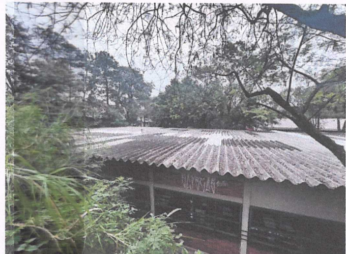
Substituição das telhas onduladas em fibrocimento
