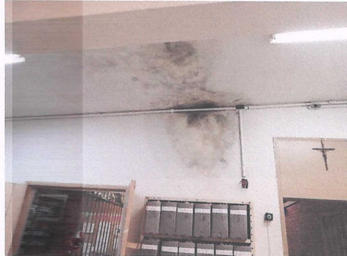
Pintura das areas afetadas pela intervenção
