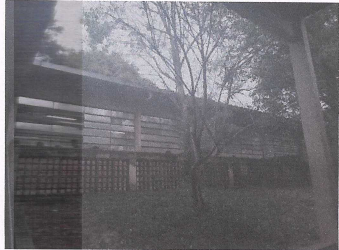
Substituição das calhas metálicas da cobertura
