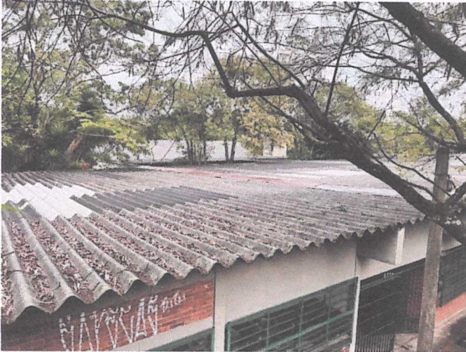
Substituição das telhas onduladas em fibrocimento
