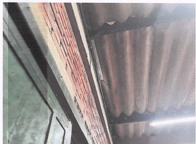
Substituição das telhas onduladas em fibrocimento
