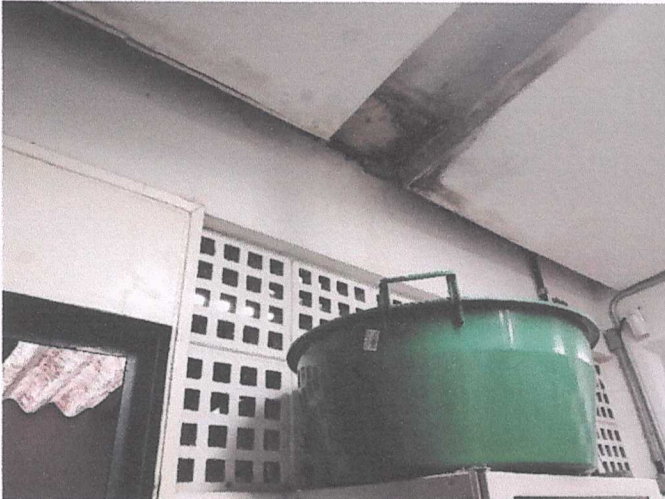
Substituição do forro em gesso acartonado na sala de informática
