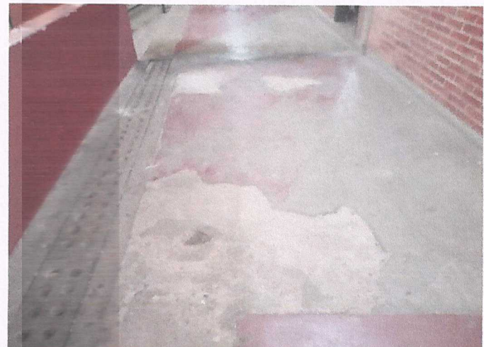
Demolição de piso cimentado para execução de piso em porcelanato
