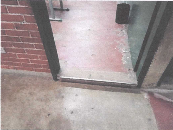
Demolição de piso cimentado para execução de piso em porcelanato
