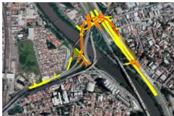
Ponte sobre o Rio Tietê/ Viaduto sobre a Rodovia Castelo Branco SP-280, Fuad Auada - km 15+800 - VISÃO GERAL DO EMPREENDIMENTO
