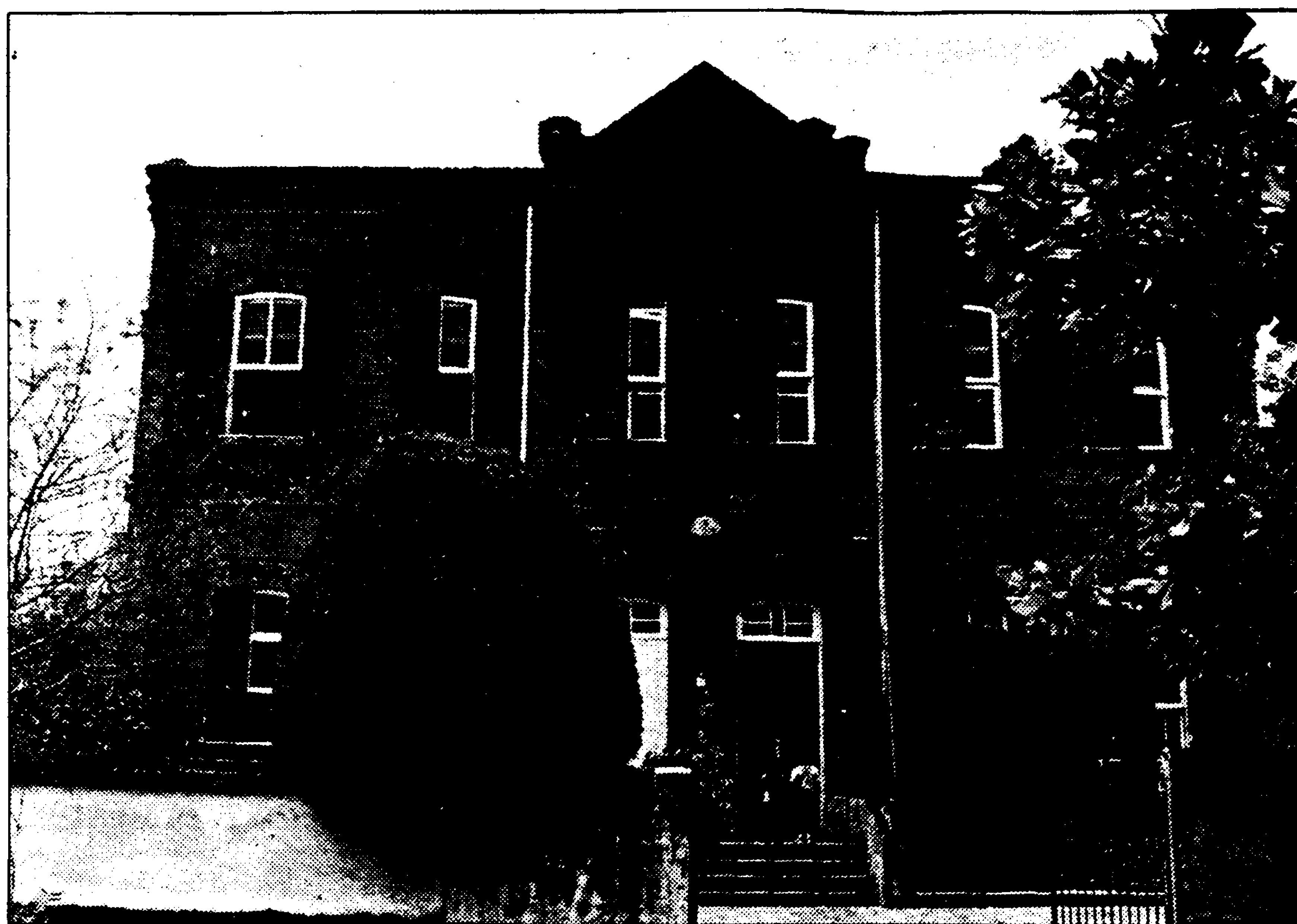
Todas as janelas do centenário prédio da creche foram restauradas
