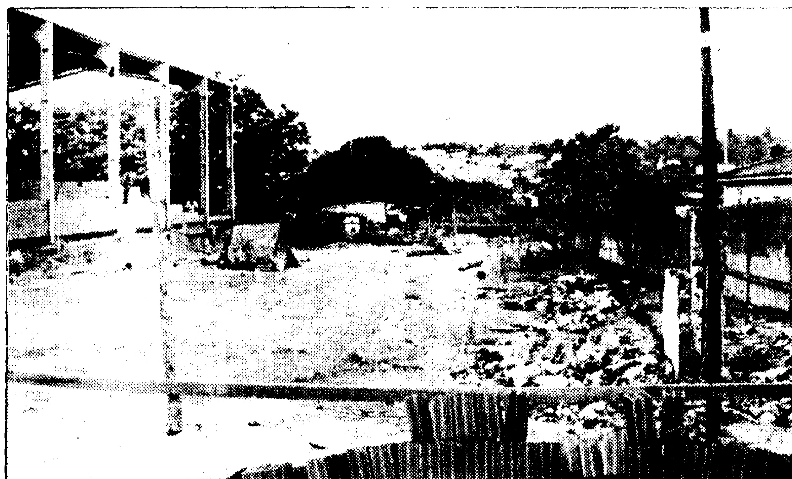
O terreno limpo, preparado para o início da construção.
