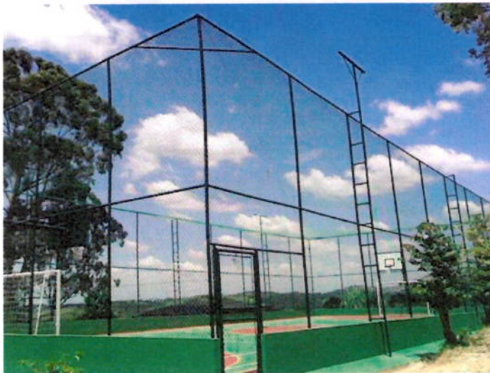
Fechamento em alambrado e mureta
